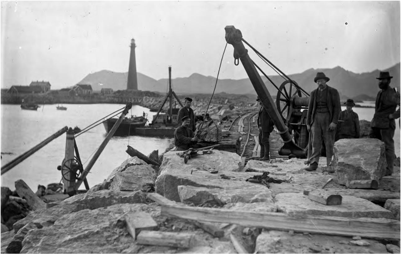
Figur 2-1 Molobygging på Andenes i 1902.
