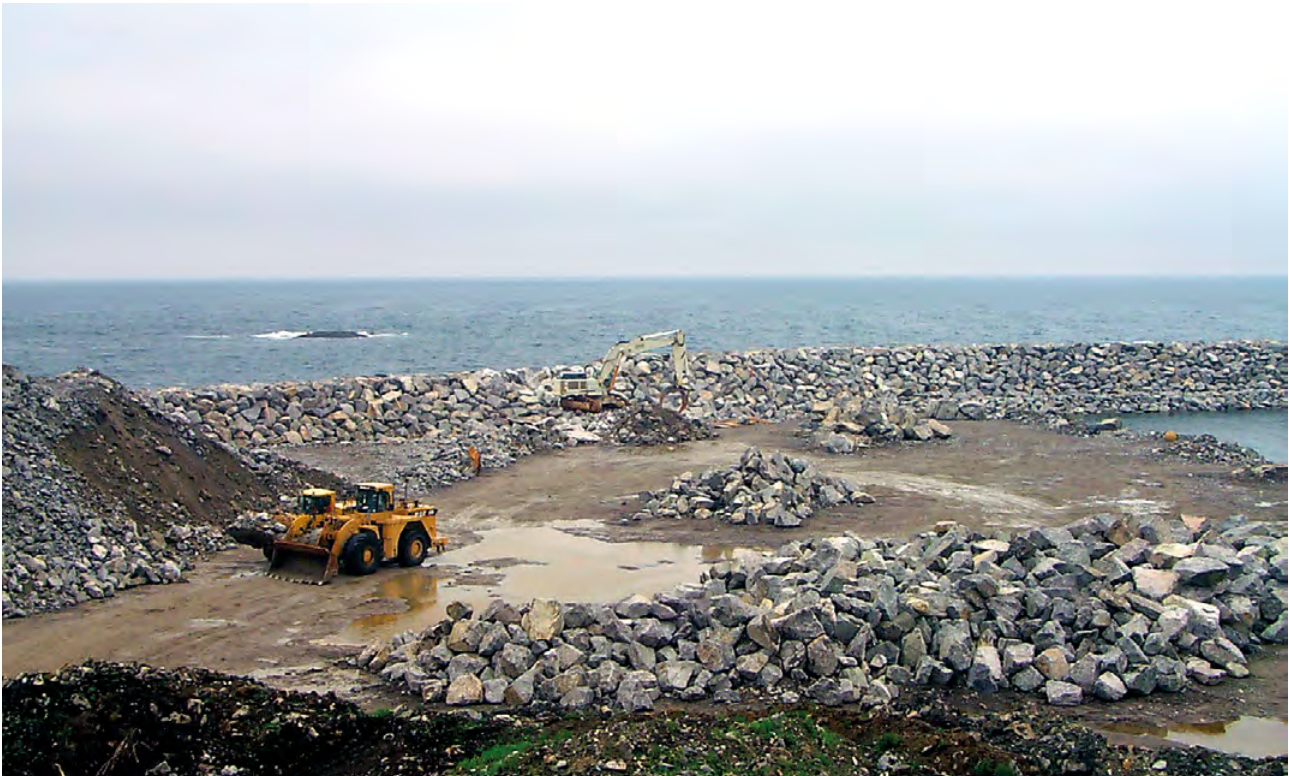
Figur 8-1 Mellomlagring av stein krever store arealer, men er en god investering ved at det gjør det lettere å oppnå ønsket kvalitet på ferdig produkt. (Sirevåg. Foto: Sintef).
