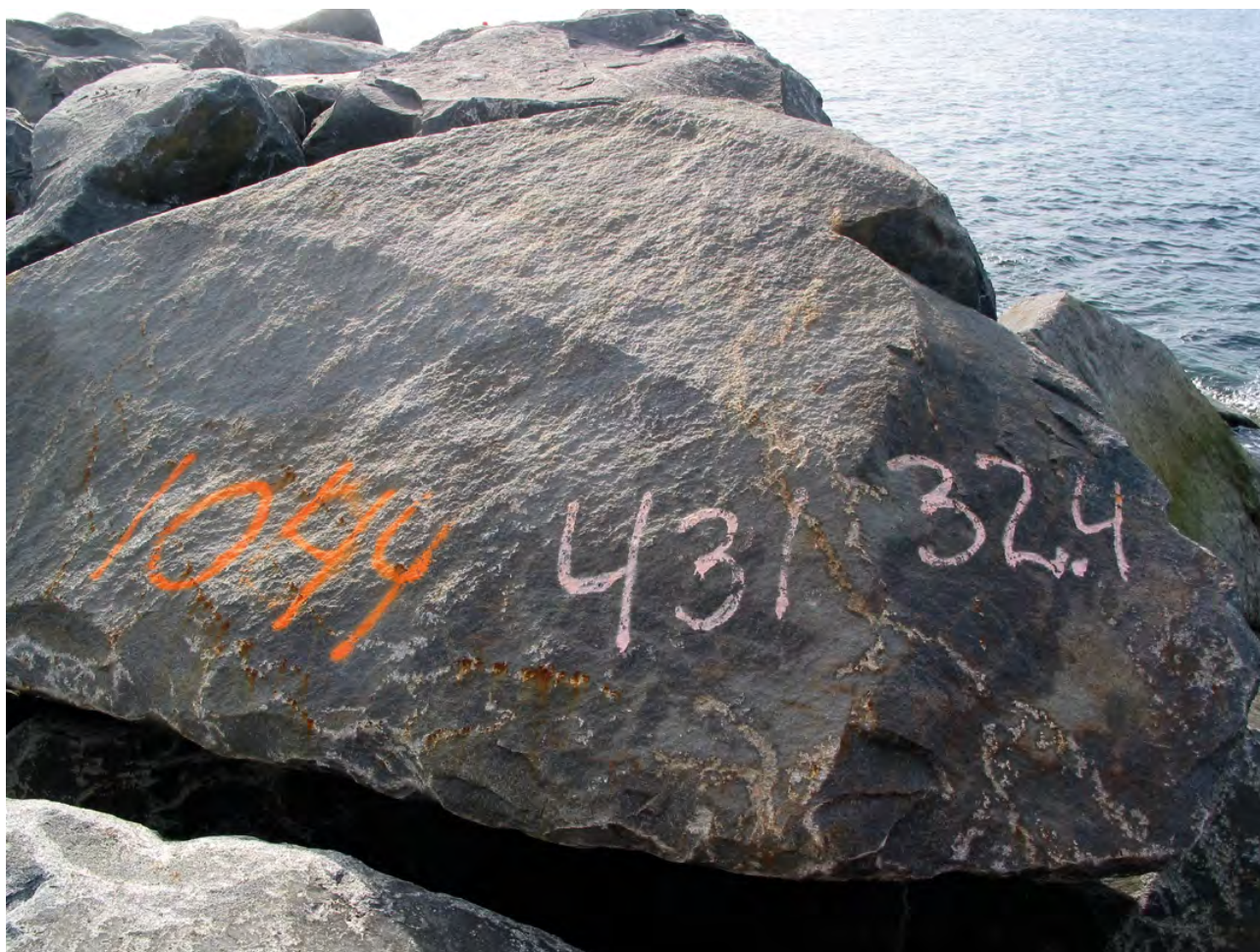
Figur 8-10 For større anlegg med sterk bølgebelastning er det aktuelt å veie og nummerere hver eneste blokk og elektronisk lagre posisjonen (vekt 32,4 tonn). (Laukvik. Foto: Norconsult).
