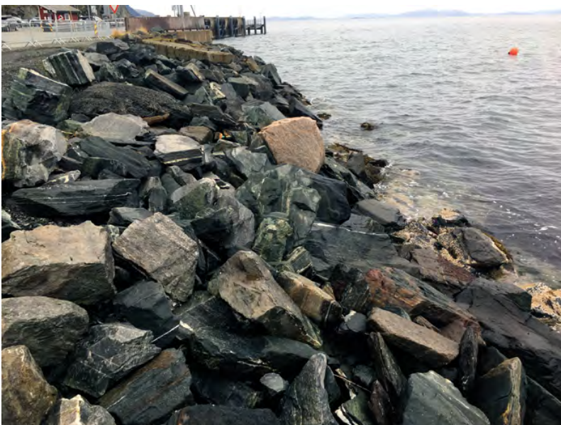
Figur 8-13 Eksempel på byggemetode I «Rauset fylling» fra tabell 3-1. (Foto: Norconsult) SKAL IKKE BENYTTES I MOLOBYGGING.
