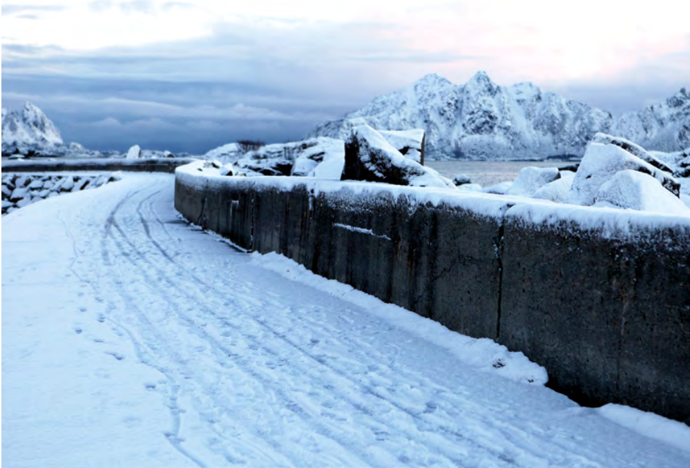
Figur 7-11 Solid utført brystvern. Oppreiste blokker med bakkant forsterkning av betong. (Svolvær. Foto: Kystverket).
