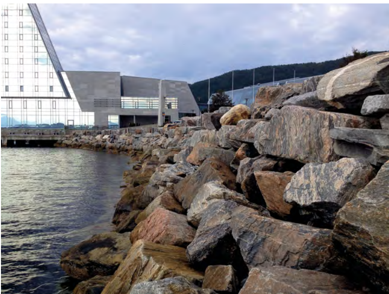
Figur 8-7 Eksempel på blokker som er godt egnet til plastring (og evt muring) – blokkene har kantet form og minst en flat side som gir godt anlegg mot andre blokker. (Molde. Foto: Norconsult).
