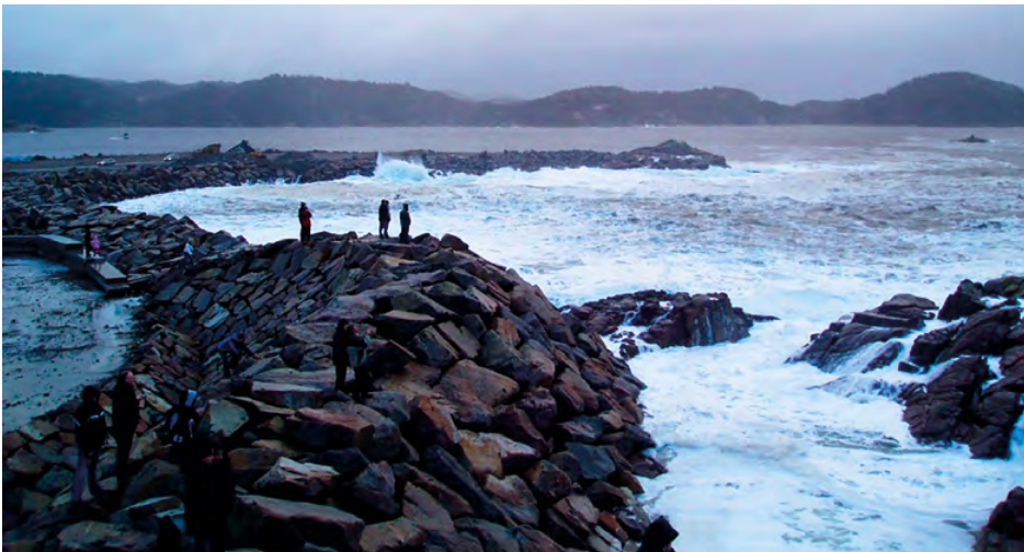
Figur 7-10 Moloer som kan eller vil bli utsatt for overskylling må plastres med like store steinblokker på innsiden som på utsiden. Man må også vurdere i hvilken grad et slikt anlegg skal være åpent for publikum. (Gismerøy, Mandal. Foto Norconsult).
