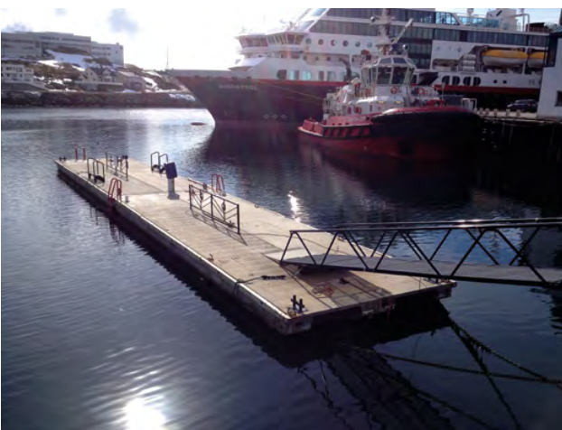
Figur 3-13 Eksempel på enkel flytebrygge (Norconsult). Disse er ment for fortøying av mindre båter i skjermet farvann, og bør ikke behandles som eller omtales som bølgedempere.
