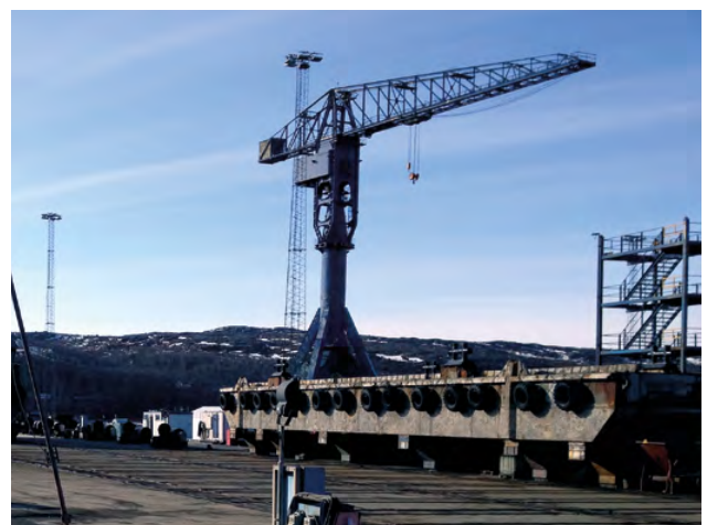
Figur 3-14 Eksempel på flytekai av ukjent opphav (Kirkenes, Norconsult). Konstruksjonen er stor og tung nok til at den vil dempe bølger opp til ca. 4-5 s periode.
