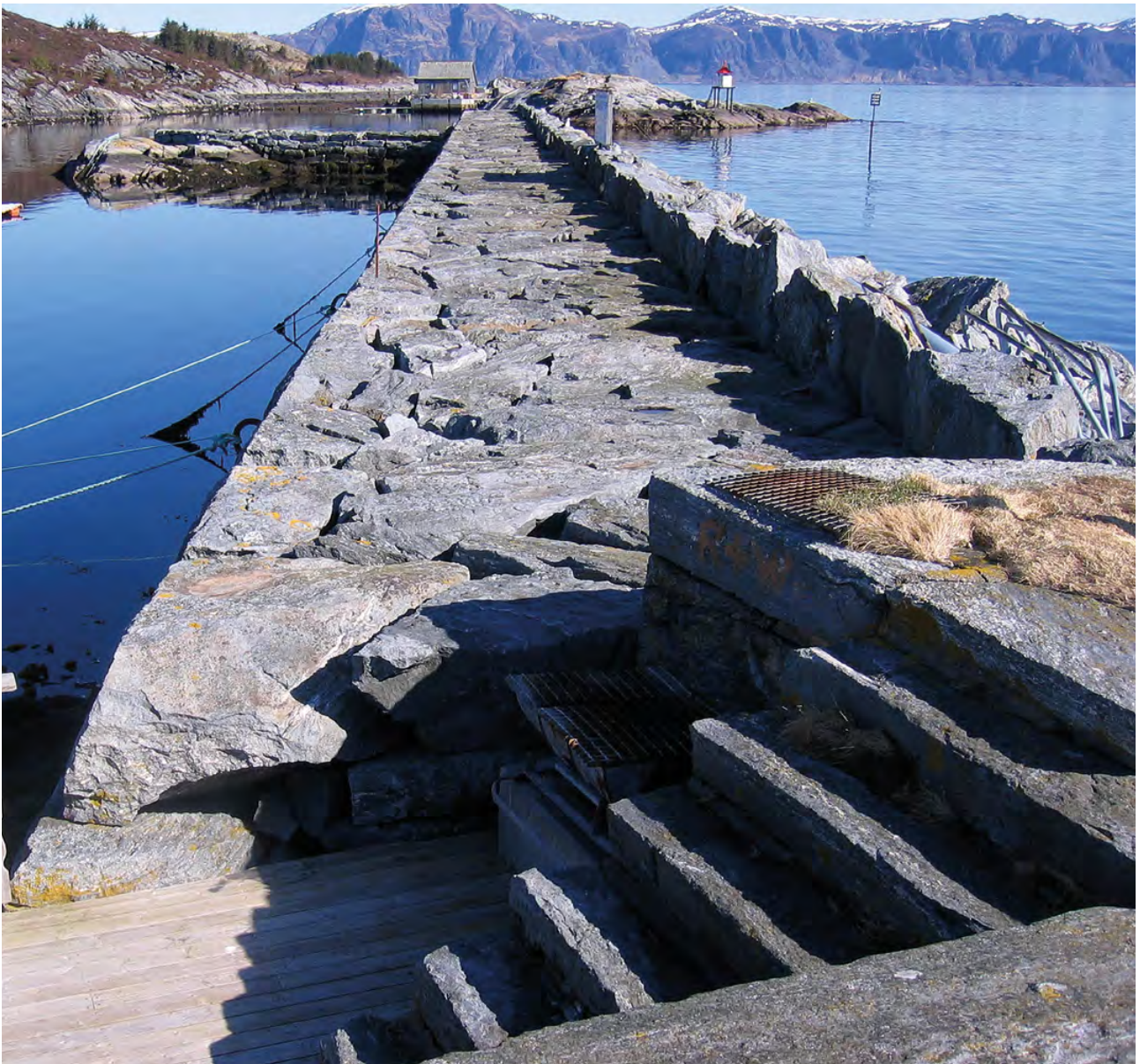
Figur 12-1 Del av moloen i Silda, Vågsøy kommune. Den eldre delen sto ferdig i 1889. Anlegget er et godt eksempel på hvordan en ved videre utbygging av moloen til en viss grad tok hensyn til byggestil og materialbruk.
