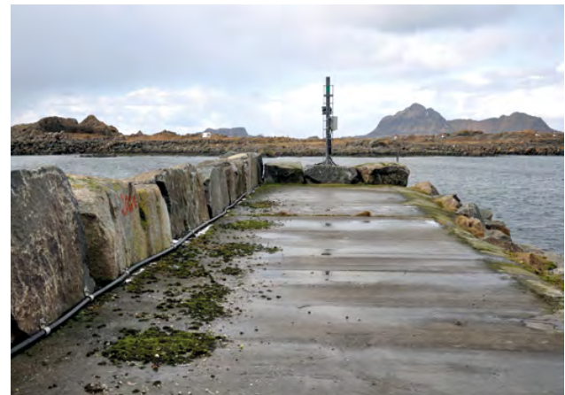
Figur 7-15 Eksempel på betongfundament og kabel klamret til brystning. (Bodø og Steinesjøen. Foto: Kystverket).
