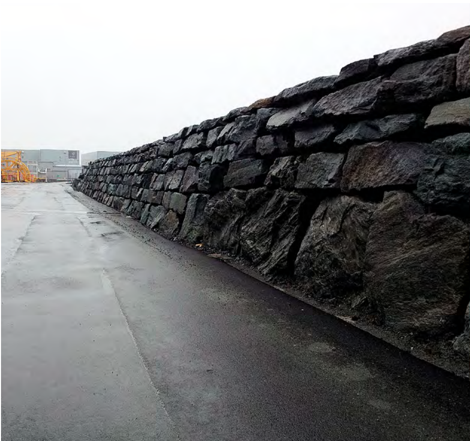
Figur 7-13 Solid utformet brystvern av stabled naturstein. Blokkene er sikret mot nedfall av gjennomgående, vertikale bolter. Dette brystvernet er så høyt at en person på kjørebane ikke har mulighet til å bedømme hvordan situasjonen på utsiden av moloen er. Moloen må derfor være så høy at overskyllingen i praksis er lik null. (Killingøy, Haugesund. Foto: Norconsult).
