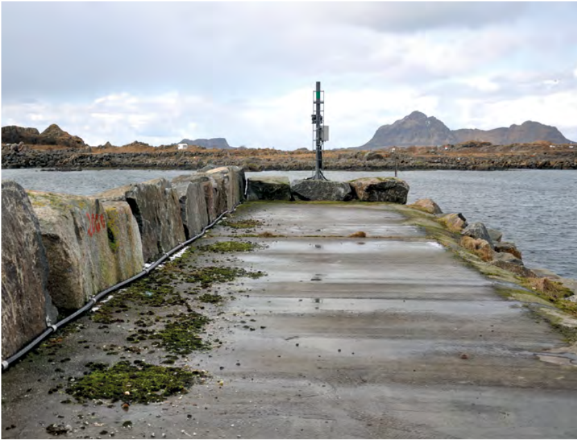
Figur 8-21 Eksempel fra Steinesjøen, Vesterålen, der det er bygd et solid brystvern av oppreiste dekkblokker. (Foto: Kystverket).
