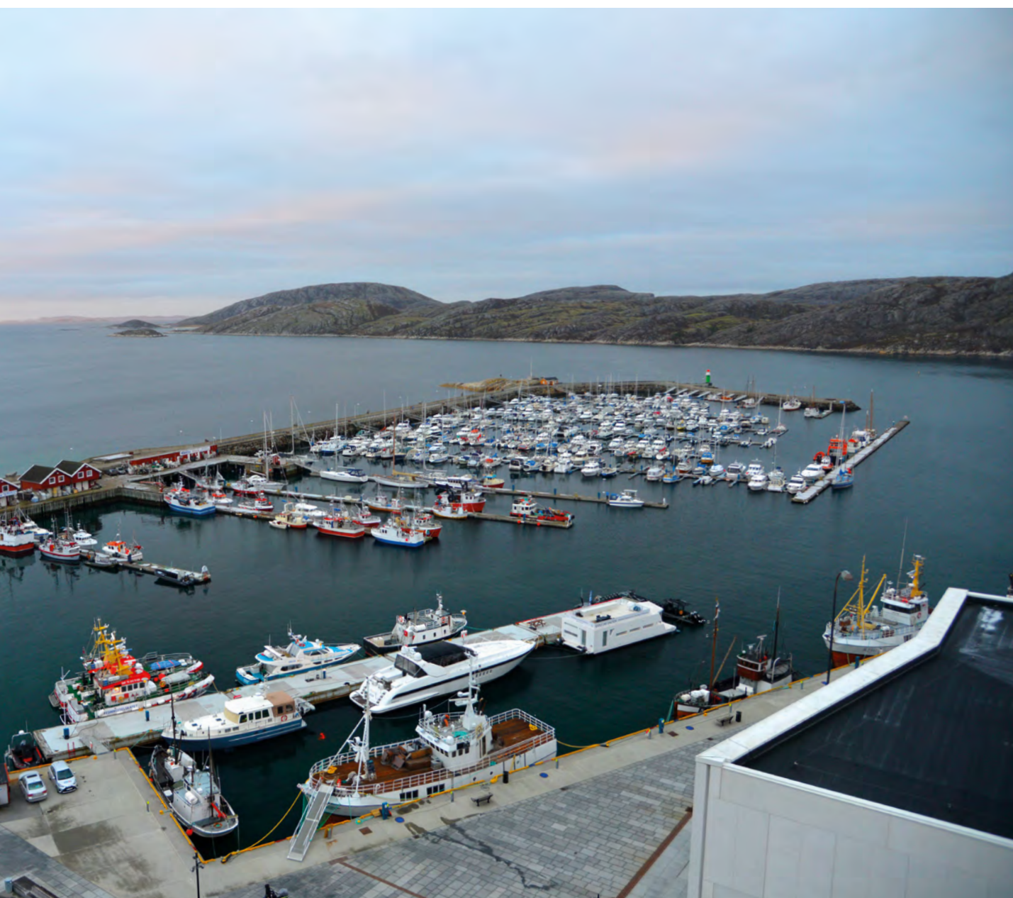
..... Figur 6-15 En molo kan ha flere bi-funksjoner. Bildet viser moloen i Bodø, som i tillegg til å skjerme havnebassenget lengre inn også er et attraktivt turområde og skjermer småbåthavna. (Foto: Statens vegvesen).
