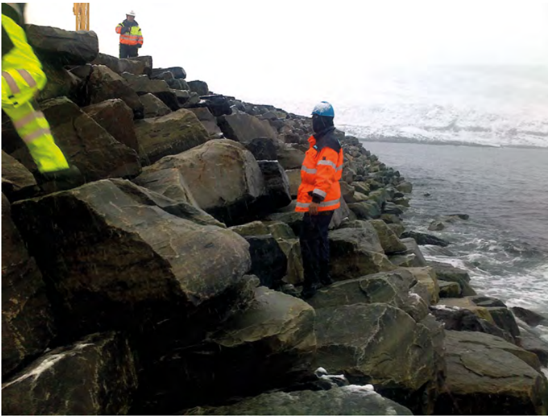
Figur 8-11 Eksempel på tilfredsstillende utført plastring: Blokkene ligger i låsing med en akseptabel helning, og peker svakt oppover. (Mehamn lufthavn. Foto: Norconsult).
