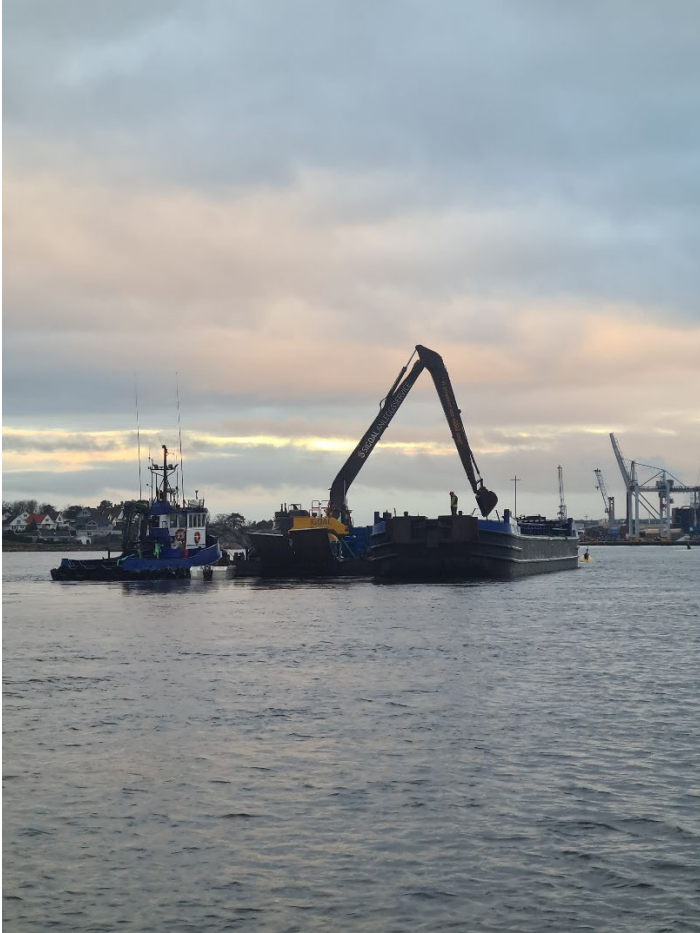
Mudreprim med bakgraver (med åpen skuffe) og tett transportlekter brukt under prøvemudring. (Felt sør, 16.11.)
