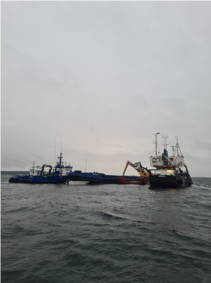
Deponiområdet. Lossing av masser fra transportlekter til nedføringsenhet (Arena). 23.11.
