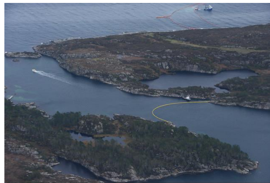
Figur 32. Sikring av tilstøtende områder. Foto: Kystverket
