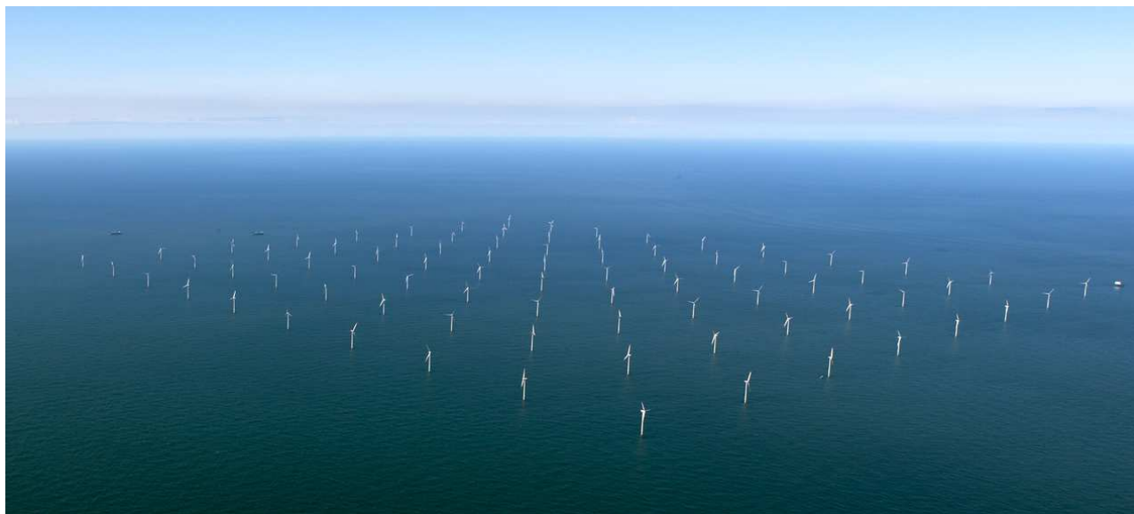
Figur 4-8 Verdens største havvindfarm «Horns Rev» i Nordsjøen utenfor kysten av Storbritannia. Vindmølleparken har hele 165 vindmøller som gir strøm til rundt 1,4 millioner husstander i Storbritannia.
