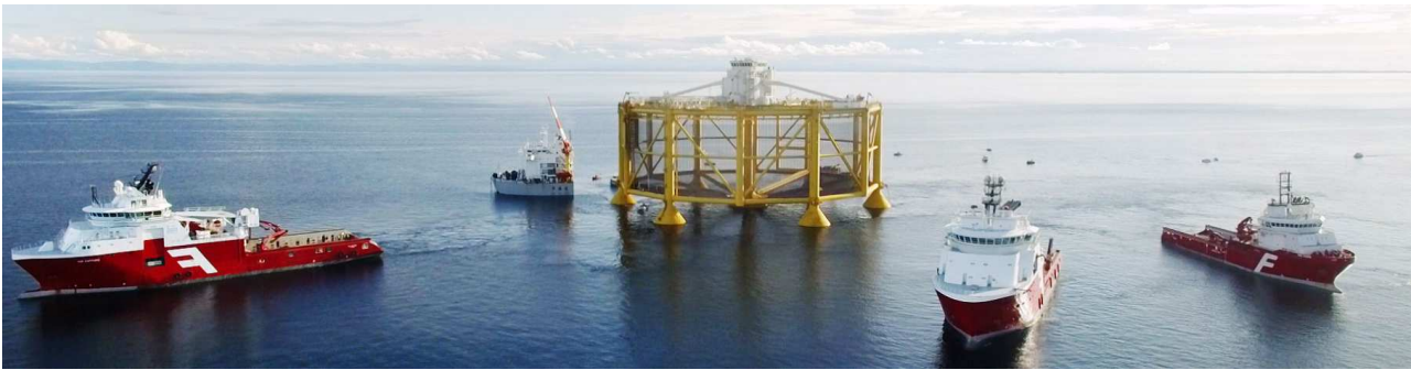
Figur 4-9 Ocean Farm 1 – Verdens første offshore havmerde for oppdrett av laks. Havmerden er bygget som en fullskala pilot og utformet for å teste ut både biologiske og teknologiske sider ved å drive fiskeoppdrett til havs [16].
