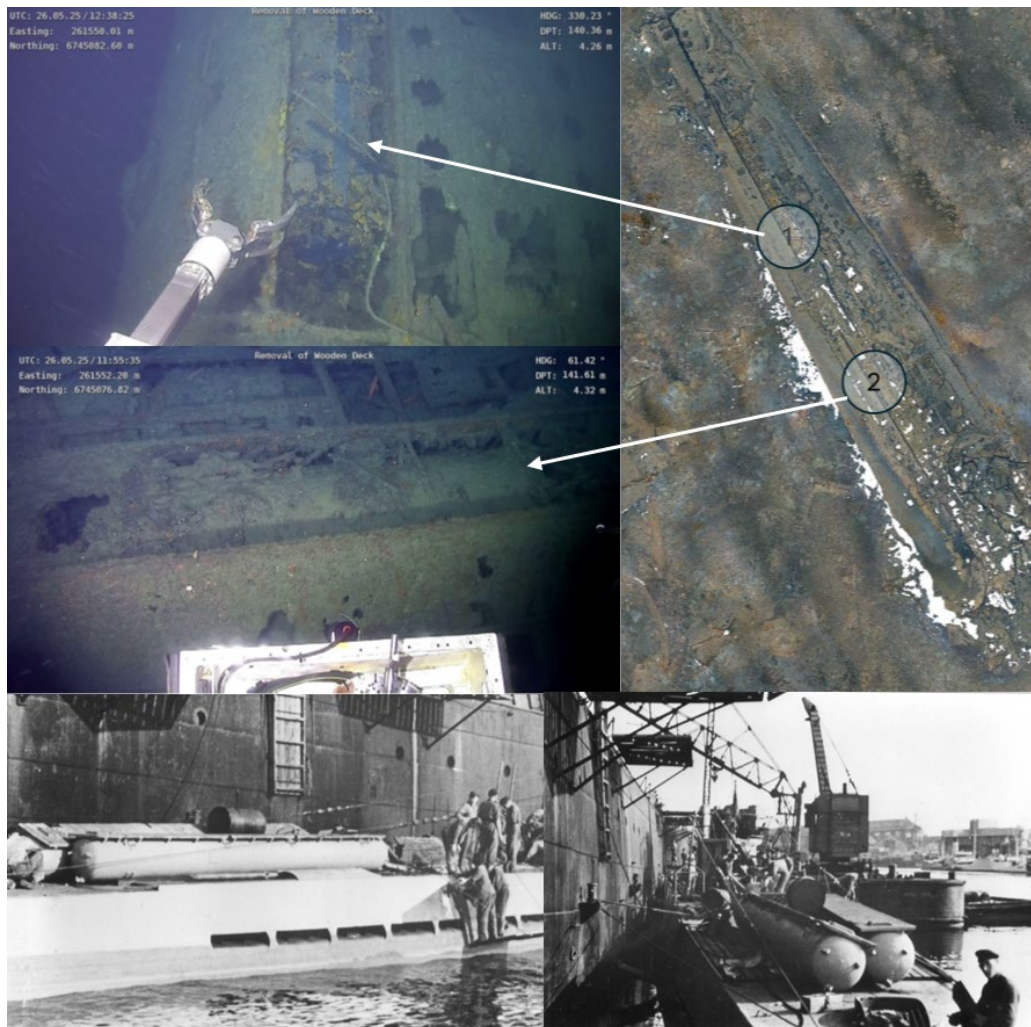
Figur 20 Bilder av lastekontainer 1 og 2 under dekket på akterseksjonen av U-864 (øverst til venstre) sammen med fotogrammetribilde av akterseksjonen (øverst til høyre) – alle fra Reach Subsea AS. Bildene under er foto av lastekontainere som klargjøres (foto: ukjent)
