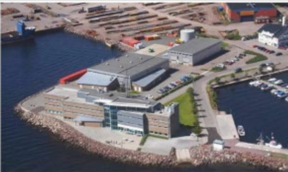
Eksisterende anlegg Horten
