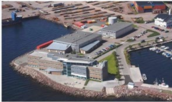
Eksisterende anlegg Horten
