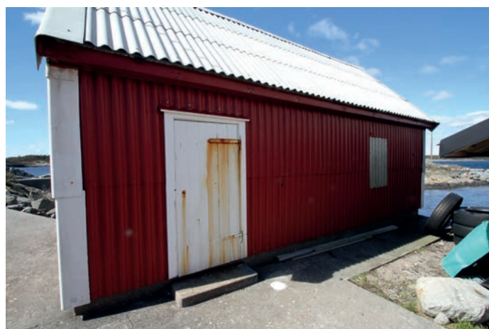
Over: Fasade mot øst.
