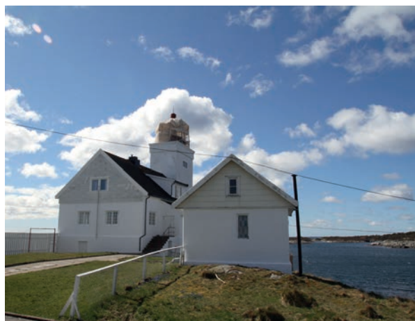
Over: Uthusets fasade mot nordøst.
