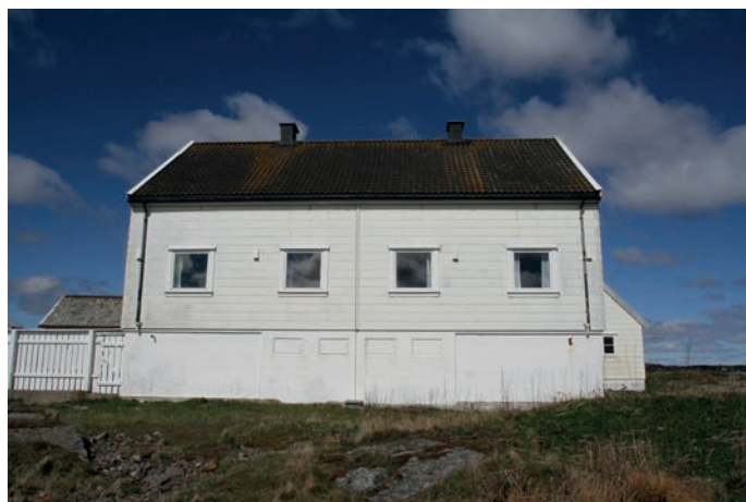
Over: Fasade mot sydøst.
