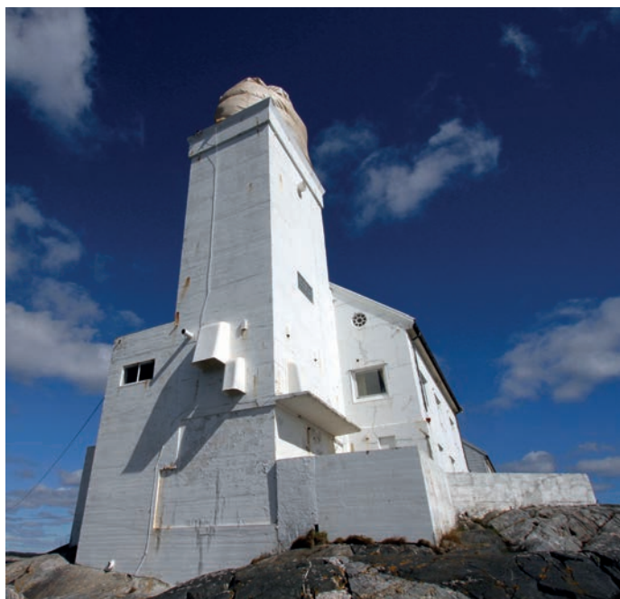
Under: Maskinhusdelen av bygningen, fasade mot sydvest.
