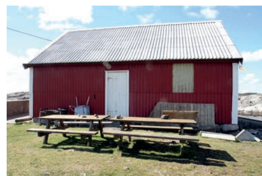
Over: Fasade mot øst.
