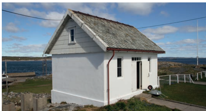
Under: Fasadehjørne mot syd.
