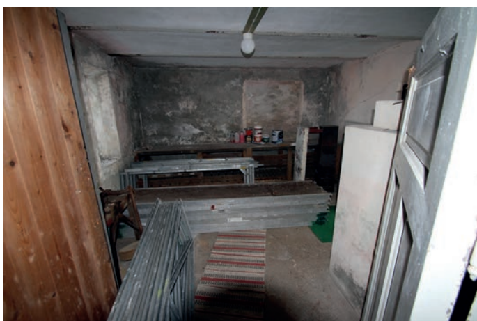
Under: (Tidl.) husholdningskjeller 1-003.
