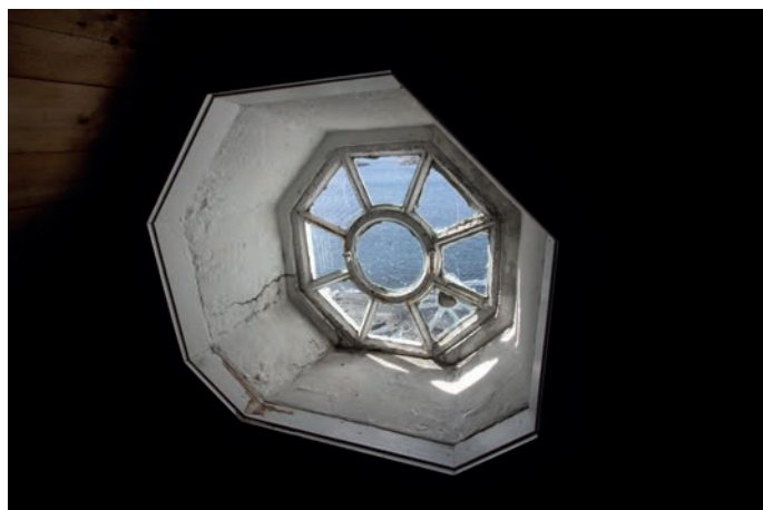
Under: Gammelt originalvindu i fasade mot sjøen, i rom 1-201.
