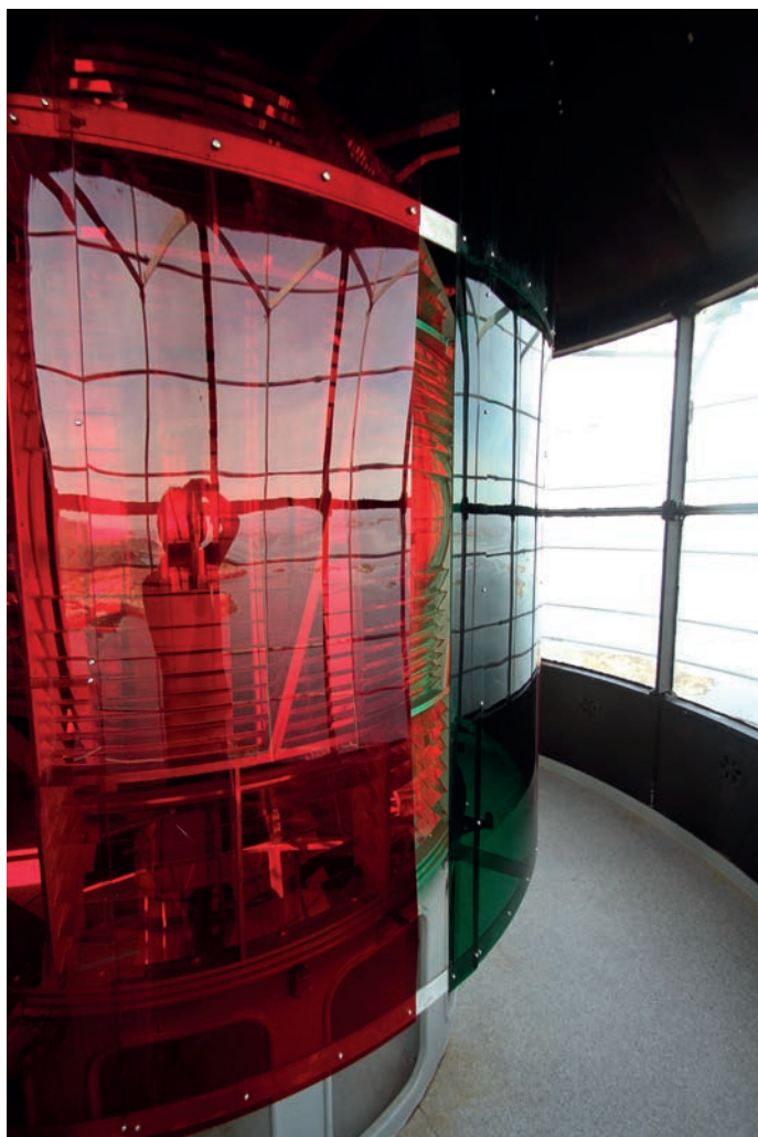
Under: Linse med skjerming, bare linse til høyre.
