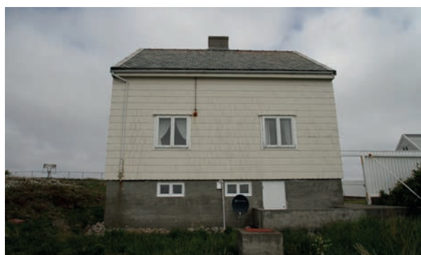
Under: Fasaden mot syd.
