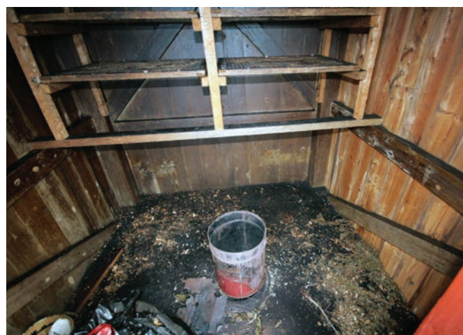
Over: Oljebod/røykebod ved naustet. Ikke nevnt som del av §15-fredning. Regnes inn under §19.
