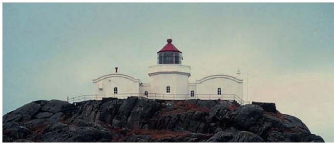
Geitungen fyrstasjon, Rogaland. Foto: Kystverket.
