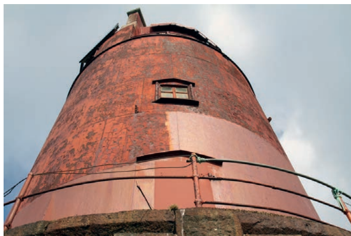
Over: Støpejernsdelen av fyrtårnet.
