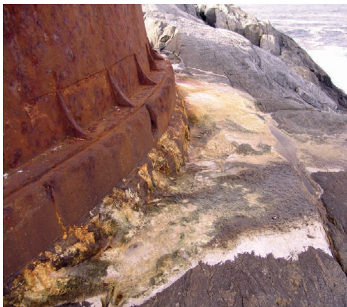
Over: Sokkelen på tårnfoten og fundamentet. T.v.: Fasade mot syd.
