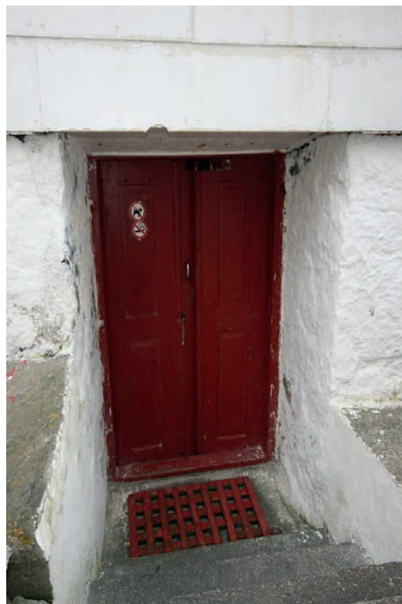
Inngang til kjeller
