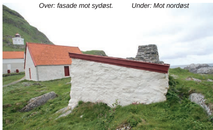
Under: Tak med beverhalestein og nylig restaurert skorstein.
