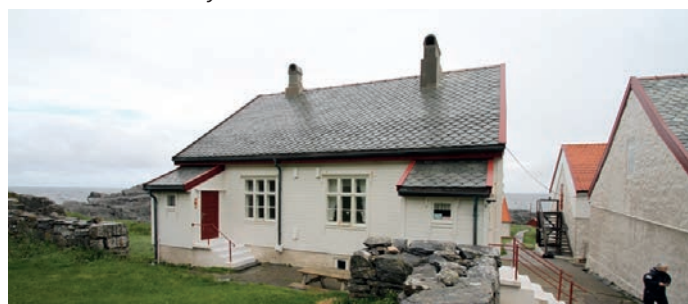
Under: Fasade mot syd.
