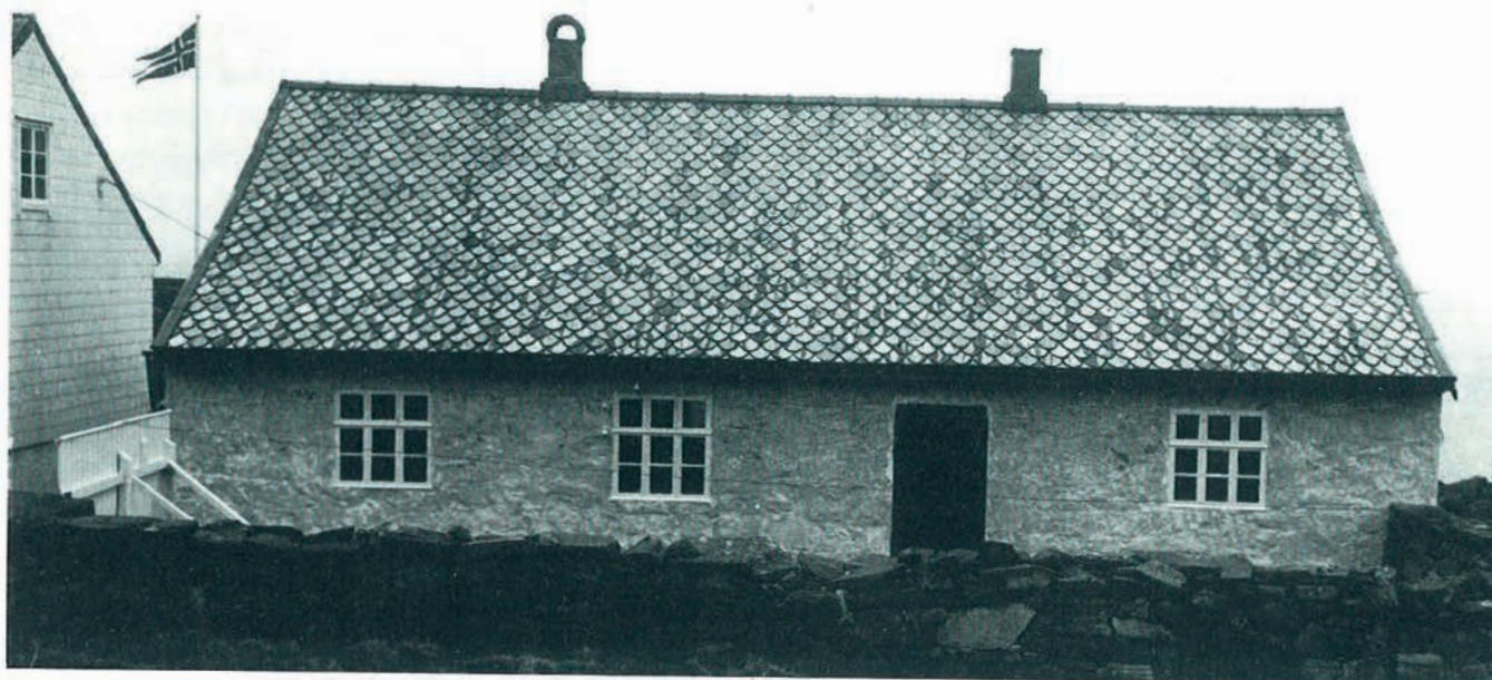
Den gamle fyrbetjentboligen sett fra syd. Foto 1981.
