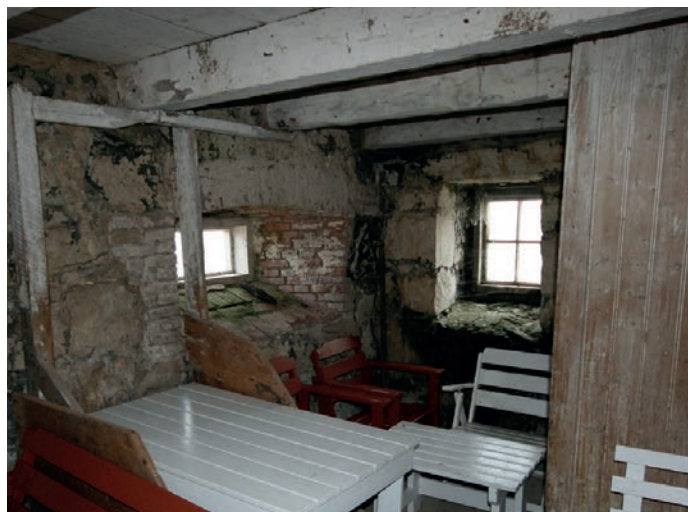
Over og nedenfor: fra 1. etasje, med stall og fjøsrom.
