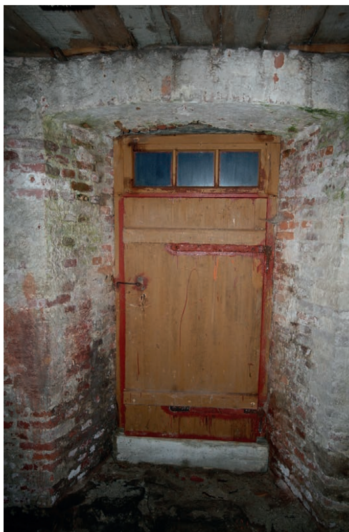
Til høyre: Ytterdør, sett fra innside.
