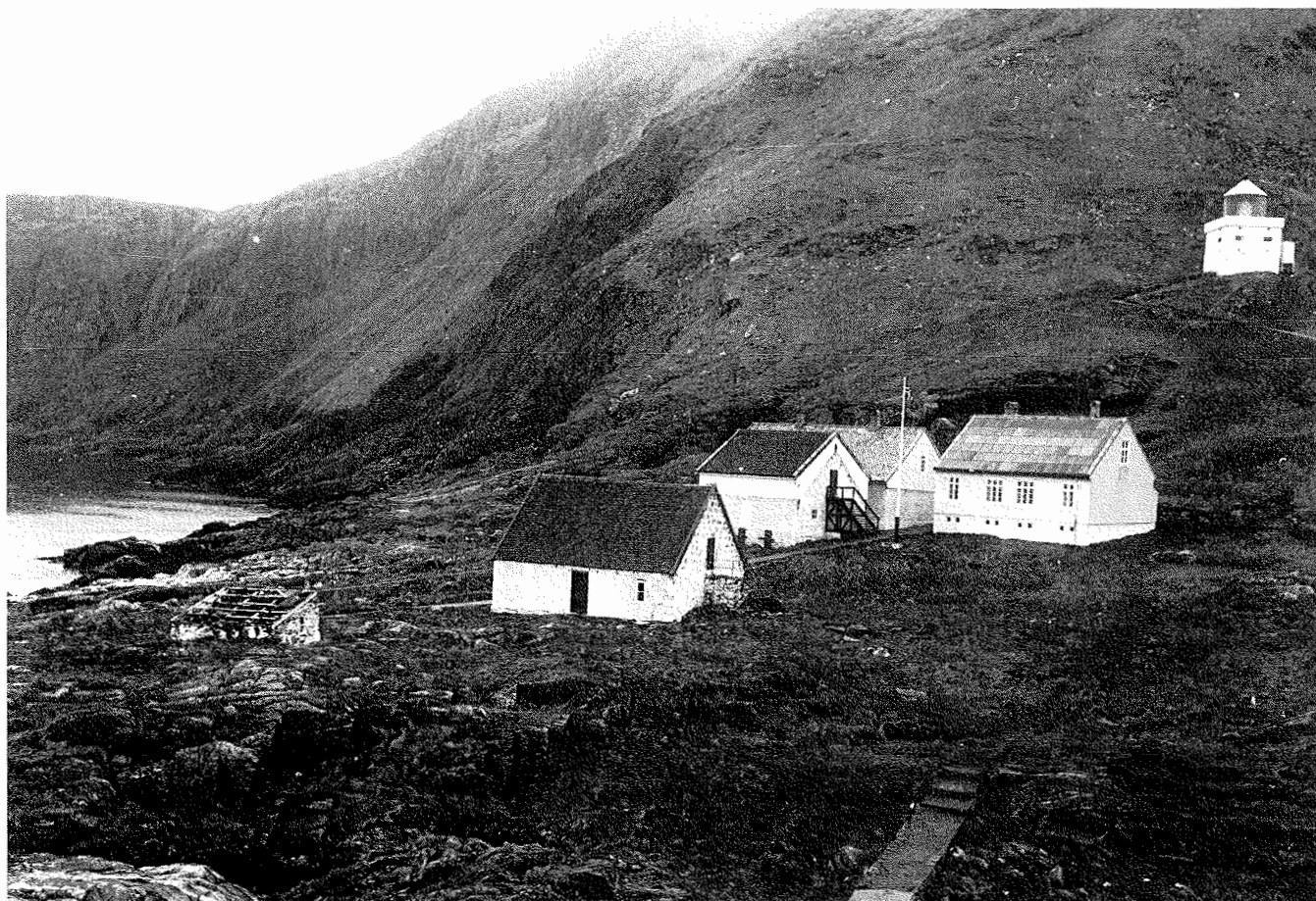
Runde fyrstasjon sett fra «Kvalen». Foto 1981.
