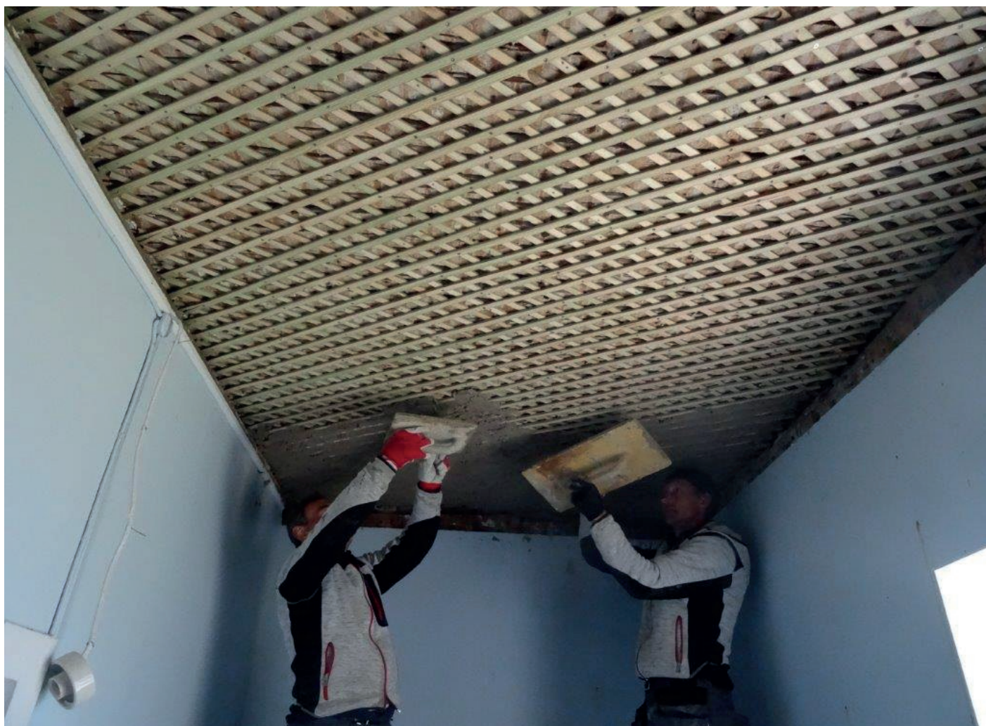
Bildene viser gammel skadet takpuss i soverom 4-108 (rappet) over, og under: nytt tak blir lagt i 2016.
