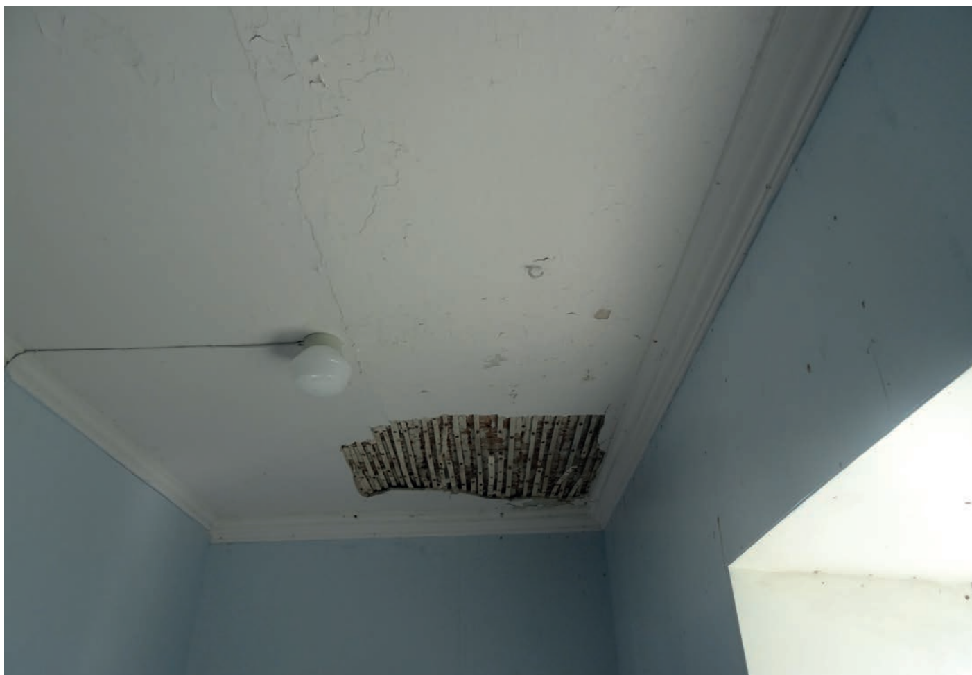
Bildene viser gammel skadet takpuss i soverom 4-108 (rappet) over, og under: nytt tak blir lagt i 2016.
