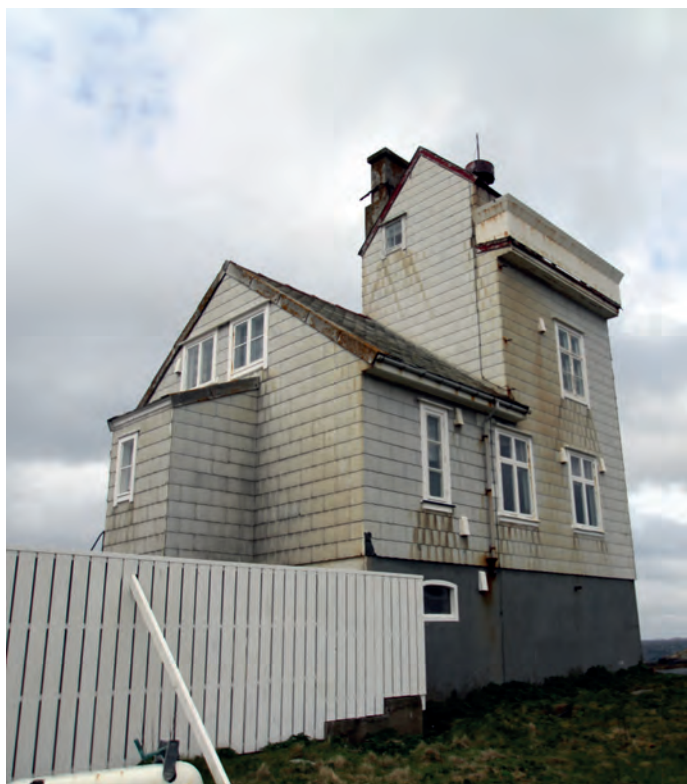
Over: Fasadehjørne mot nord-øst.
