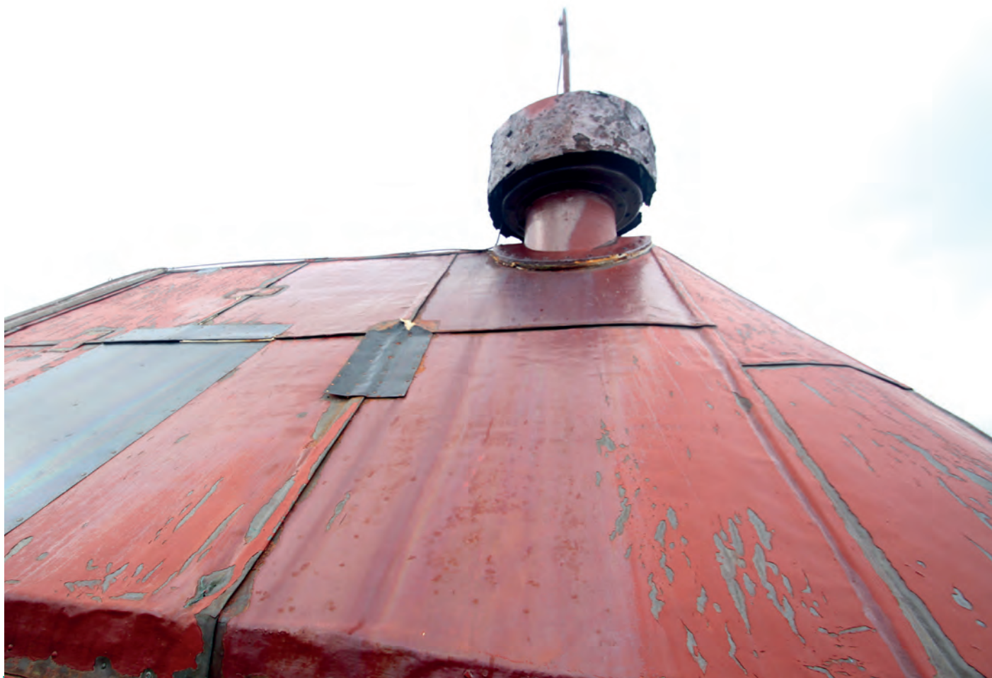
Rust-tæret ventilasjonshatt på fyrlykt-taket.
