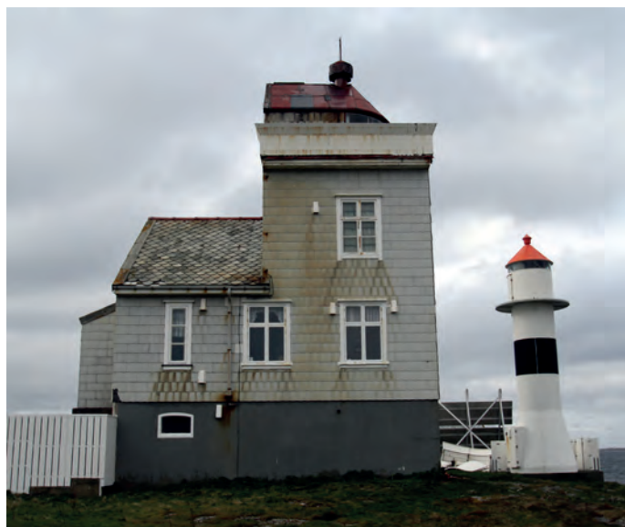
Over: Fasade mot nord.
