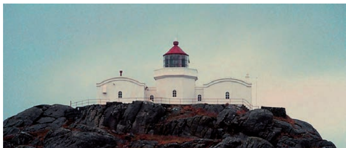
Geitungen fyrstasjon, Rogaland. Foto: Kystverket.
