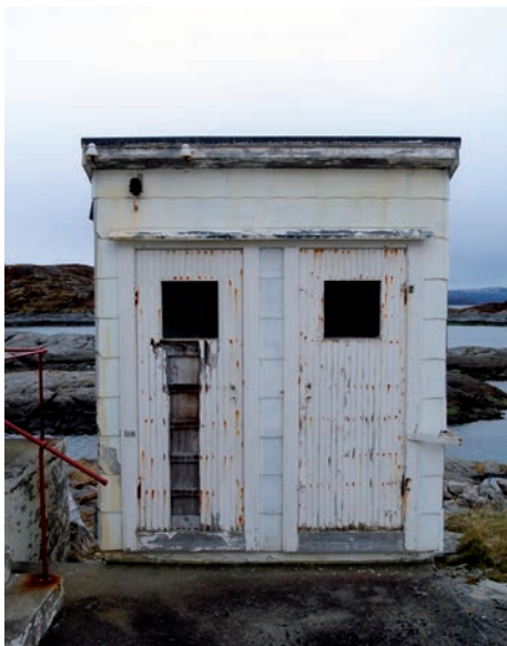
Over: fasade mot nord.
