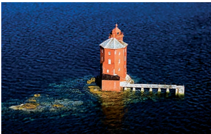
Kjeungskjær fyrstasjon, Sør-Trøndelag. Foto: Kystverket.
