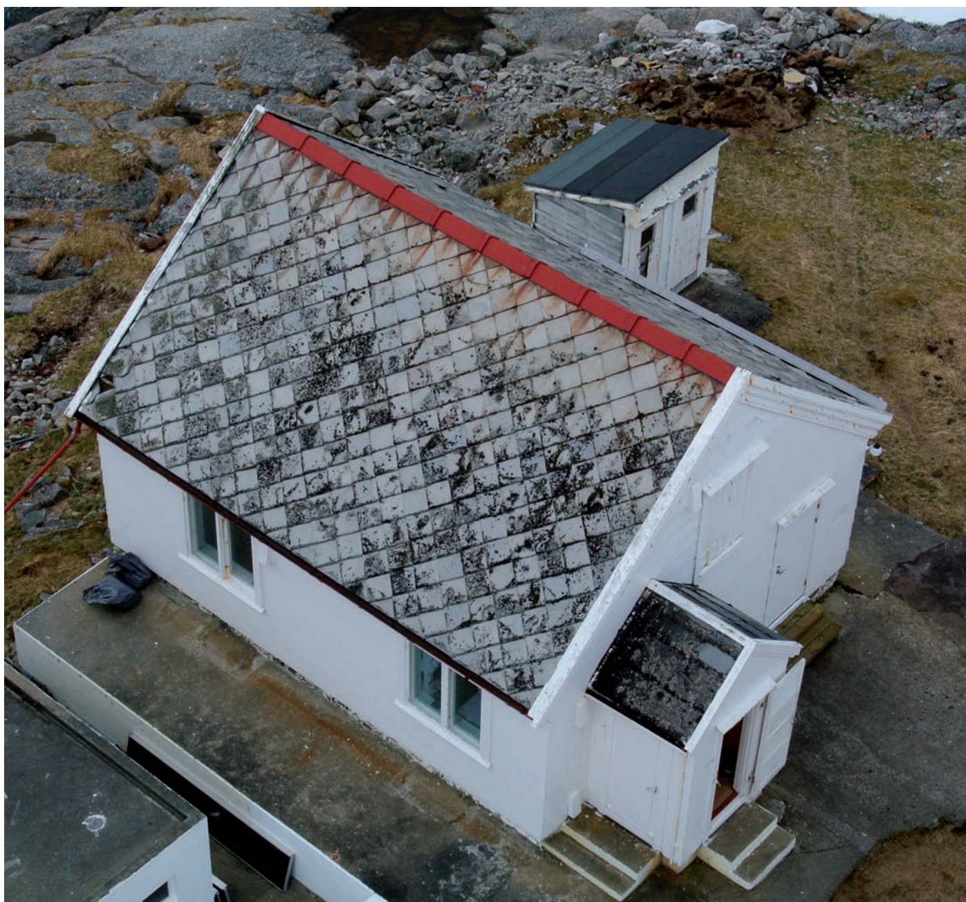
Foto av uthusets skifertak mot syd. Foto: Kystverket 17.2.2010.
