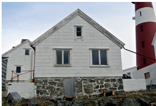
Over: Fasade mot syd. Inngang kjeller.
