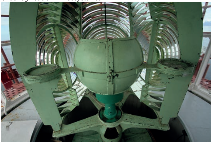
Under og nede t.v.: Linsesystemet.
