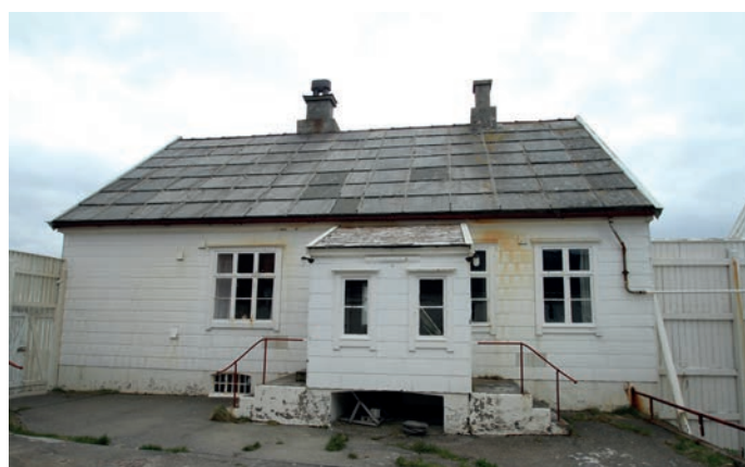
Over: Inngangspartiet mot nord-vest.
