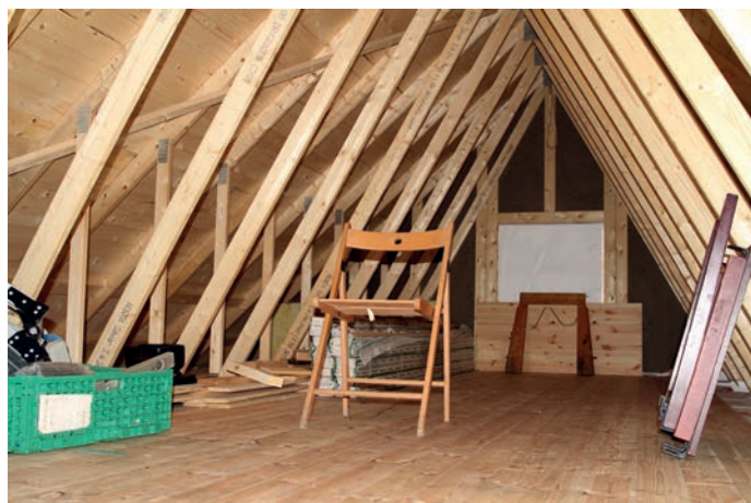
Under: Loftet med takstol-konstruksjon.
