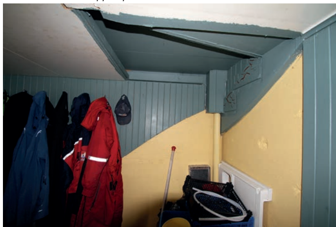
Under: Rester av trappeløp i rom 3-011.
