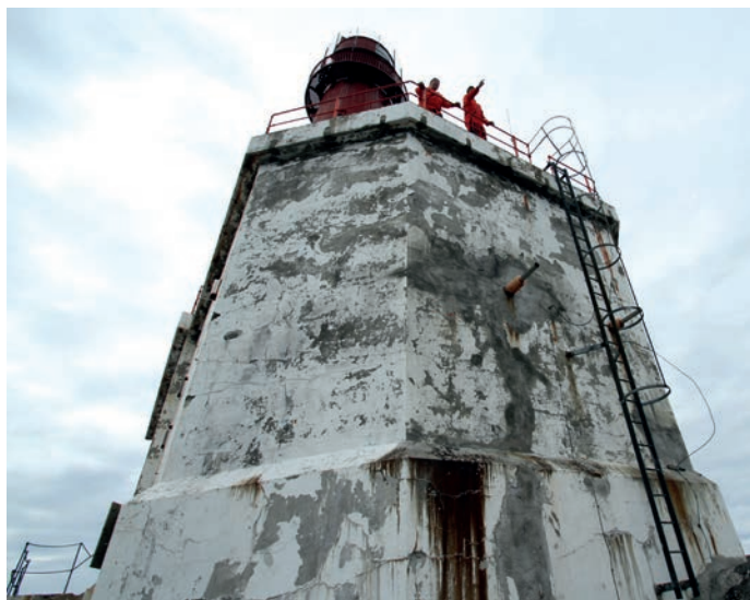
Over: Nordøstfasaden på maskinhuset.
