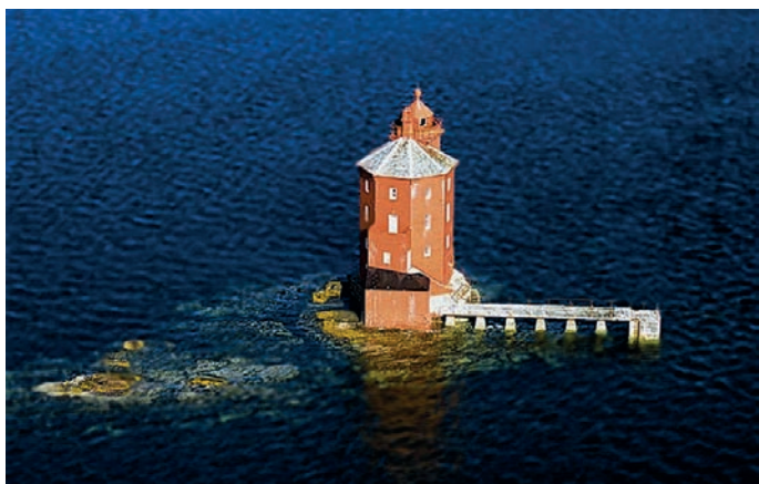
Kjeungskjæret fyrstasjon, Sør-Trøndelag. Foto: Kystverket.
