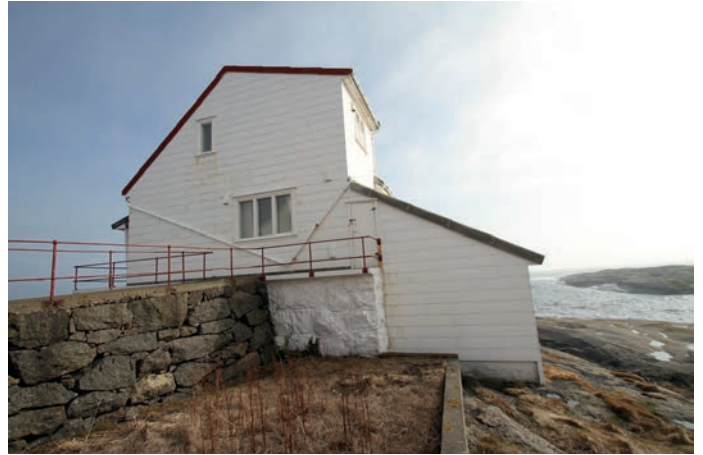
Over: Fasade mot nord.
