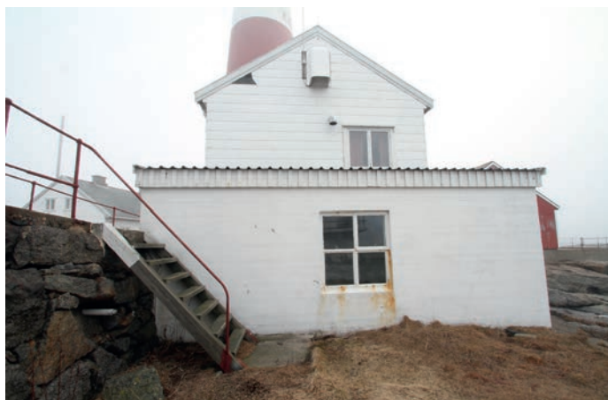
Over: Maskinhusets fasade mot syd. T.h.: Mot øst.
