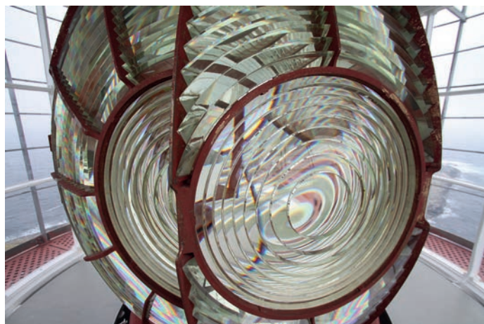
Foto av ulike deler av fyrstårnet, som viser galleri med rekkverk, typiske støpejernsvinduer og linsen.
