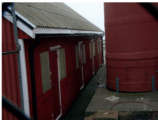
Fra vest-siden av naustet. Eldre vinduer bak glassfiberplatene.
