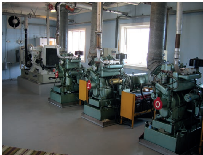
Over: Fra maskinrommet. Under: Fasade mot vest. Alle foto: Kystverket 15.4.2013
