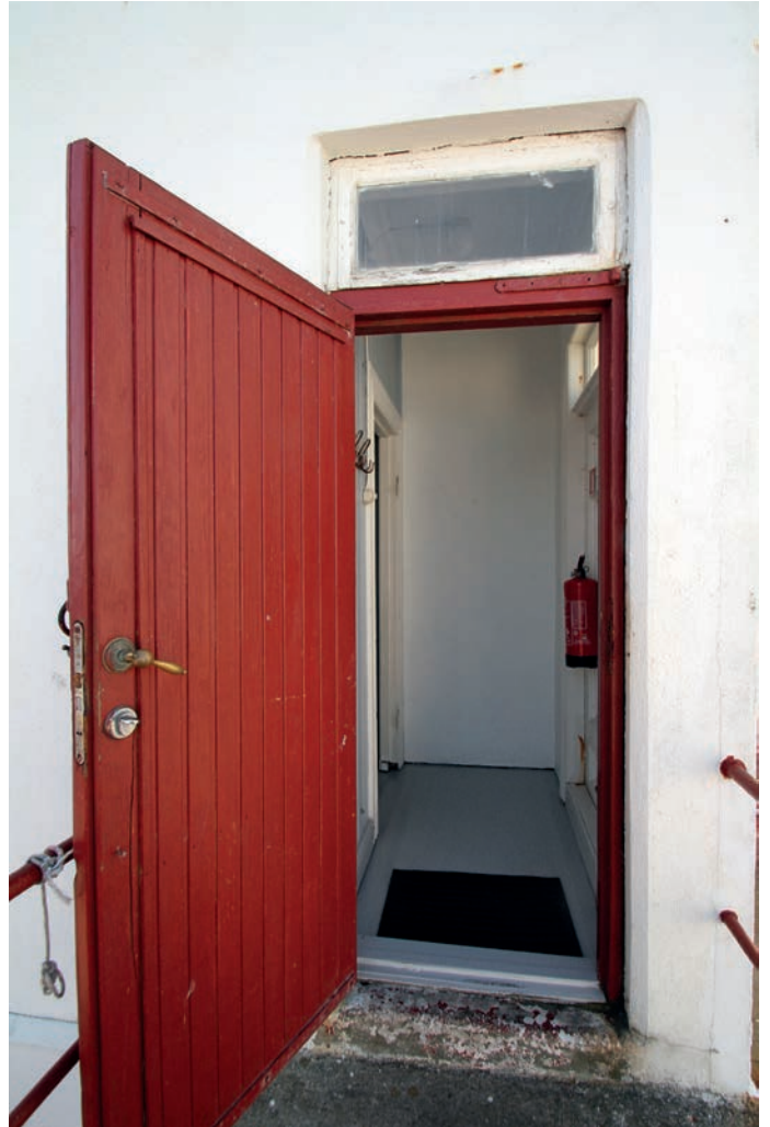
Over: Inngang fra nordvest.
