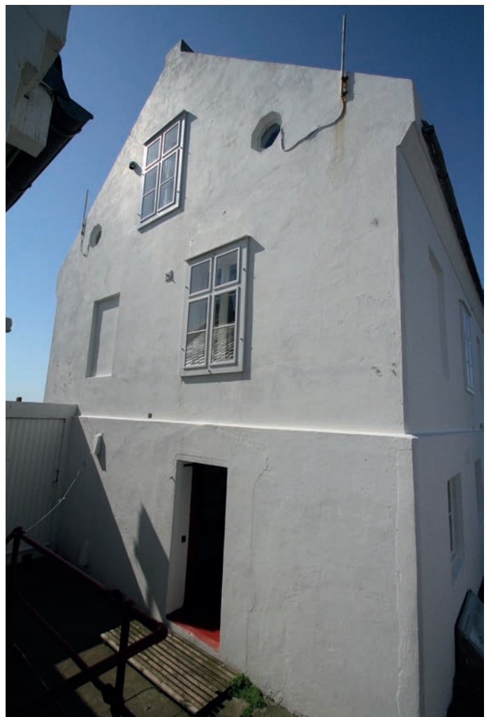
Under: Fasade mot nordøst.
