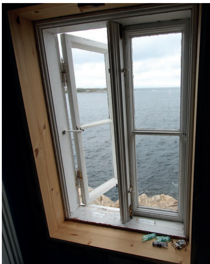
Rømningsvindu i 2. etasje. Midtposten svinger ut med høyre vindusfag. I rom 1-204. Kystverket 2015
