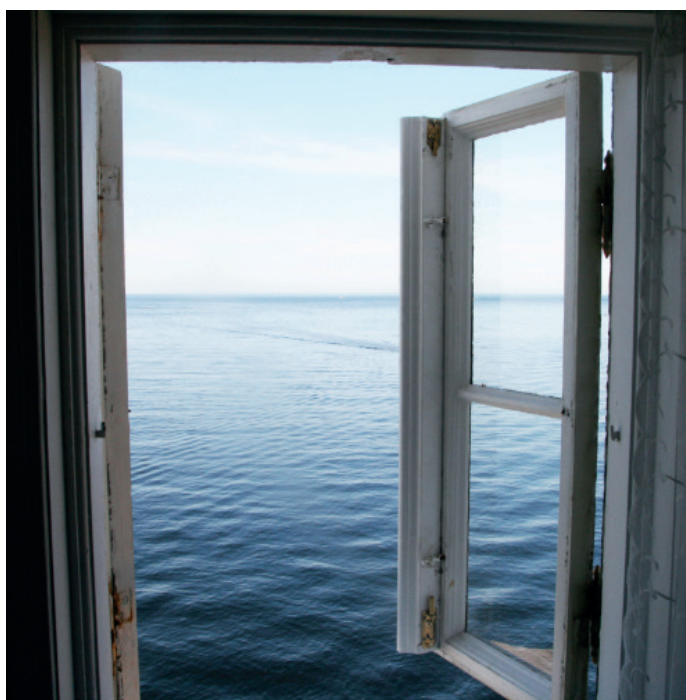
Rømningsvindu i 2. etasje. Midtposten svinger ut med høyre vindusfag. I rom 1-204. Kystverket 2015
