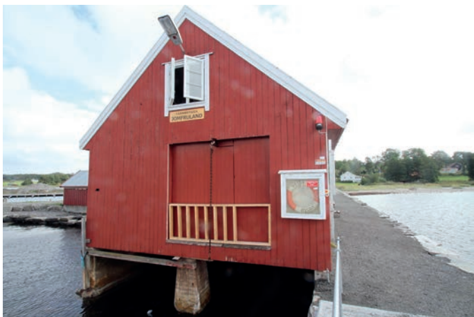
Naustet; øverst: Fasadehjørne mot nord-øst.
