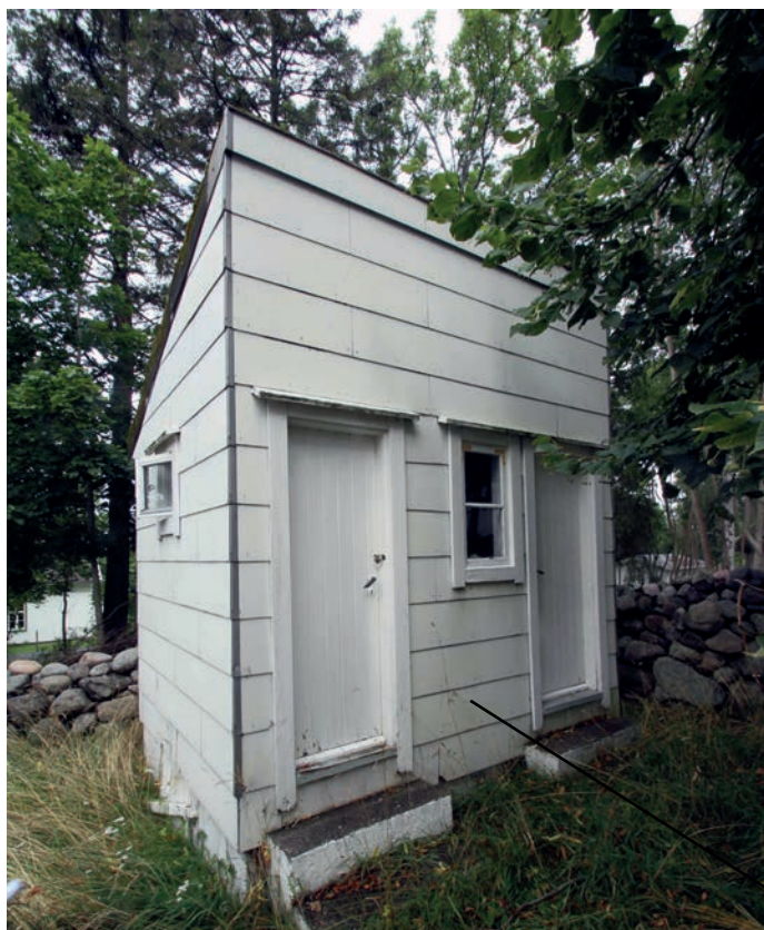
Andre bygg, fredet etter §19, områdefredning: Assistentens utedo/uthus.
