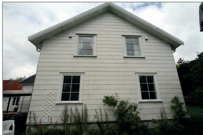
Over: Fasade mot øst.
