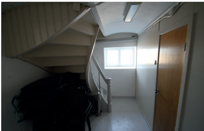
Over: Trapp ned til kjeller i boligen.
