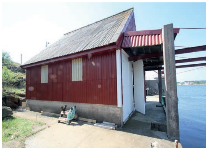
Over: Fasadehjørne mot nord.
