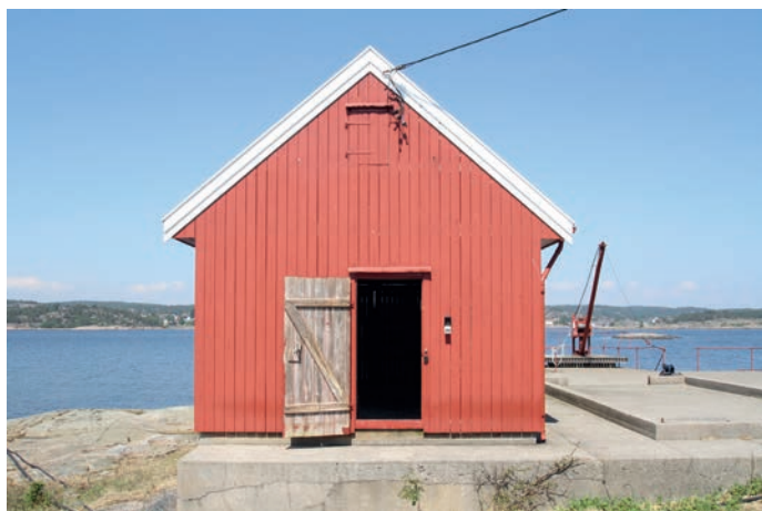
Over: Fasade mot sydøst.
