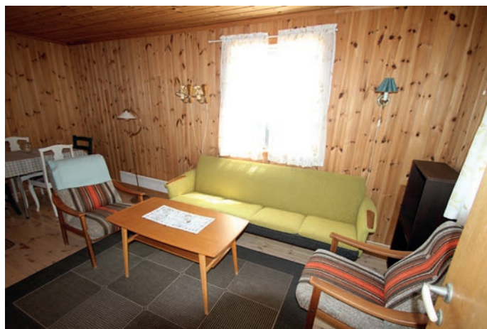
Over: Oppholdsrom 4-02. Bilde tatt før rommet ble malt.
