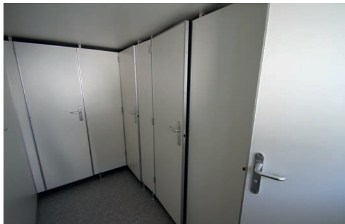
Over: Fra samling av dusjer i fellesbad, sanitærrom 6-012.
