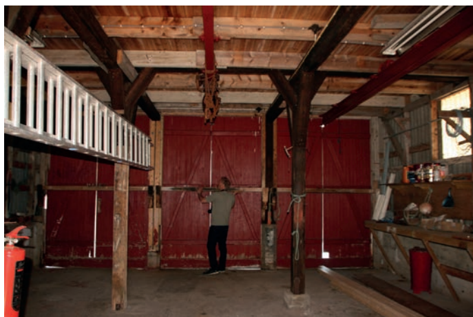
Under: Naustet, veggen mot nord med 3 doble porter.
