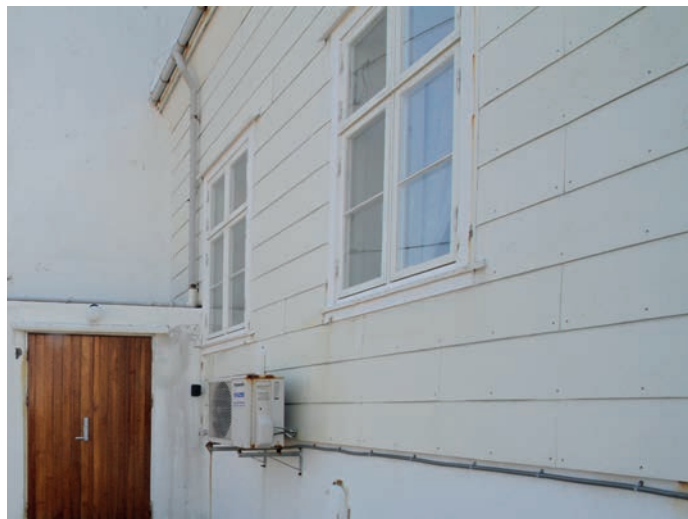
Over: Etter skifting / tilbakeføring av vinduer i 2014.
