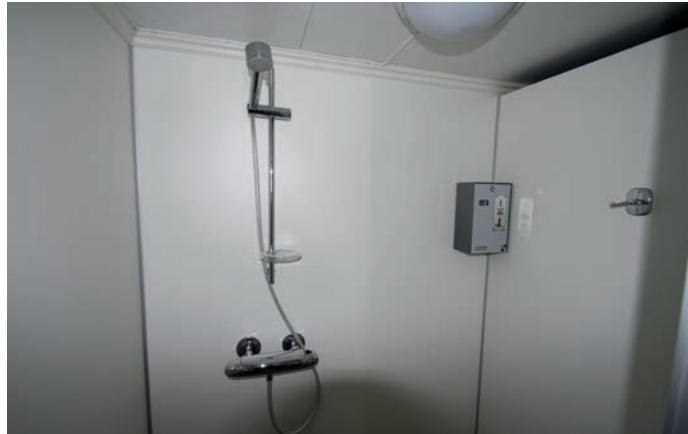
Under: Fra en av dusjene i rom 6-012.
