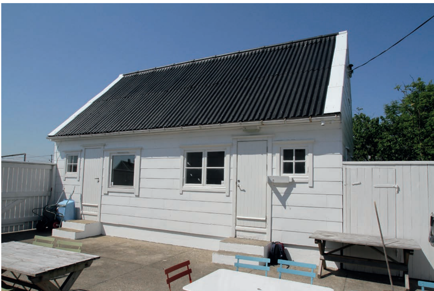
Under: Fasade mot gårdsplass, mot sydøst.
