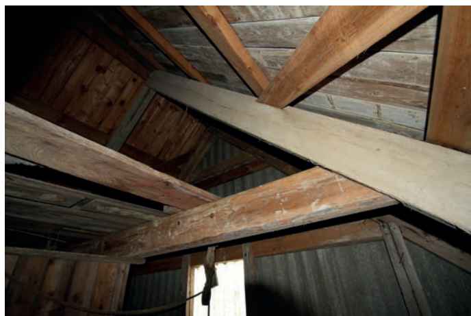
Under: Del av tak-konstruksjonen.
