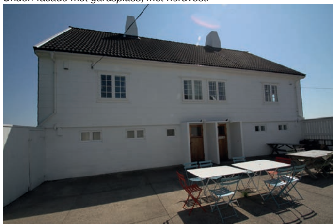
Under: fasade mot gårdsplass, mot nordvest.
