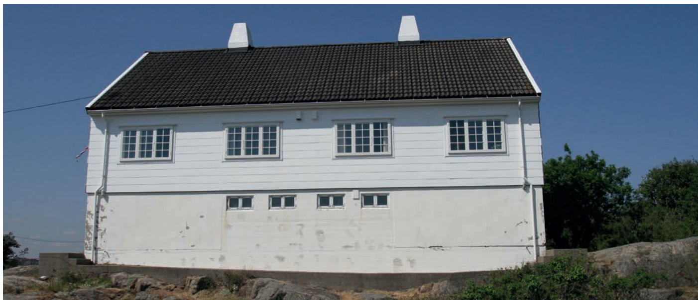
Over: Fasade mot sørøst.
