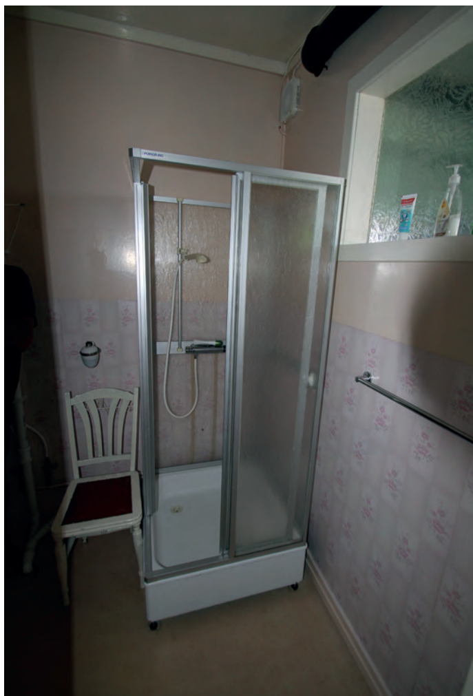
Over: Dusj/bad i 1. etasje, A-110.
