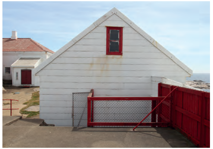
Over: Fasade mot nordvest.
