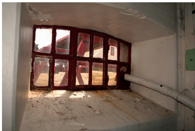
Under: Støpejernsvindu i kjeller.
