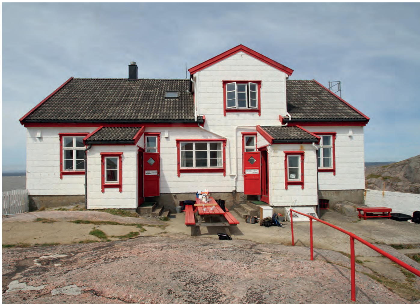
Over: Fasade mot sydøst. Under: Fasade mot sydvest.
