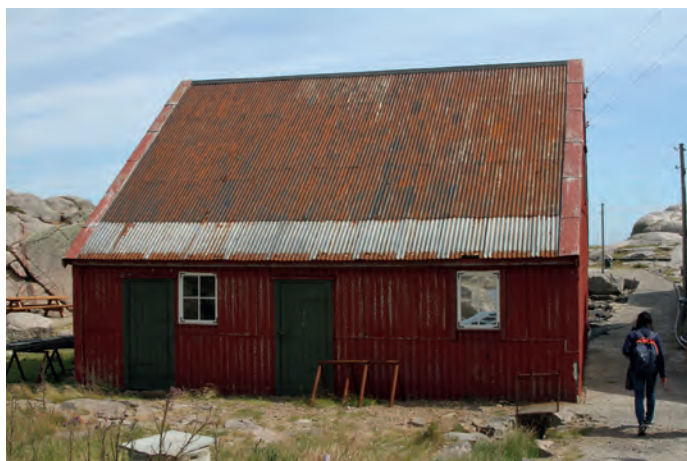
Over: Fasade mot nordvest.
