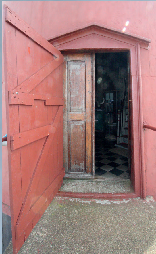
Over: Labankdør ytterst, så en indre dør av mahogny.
