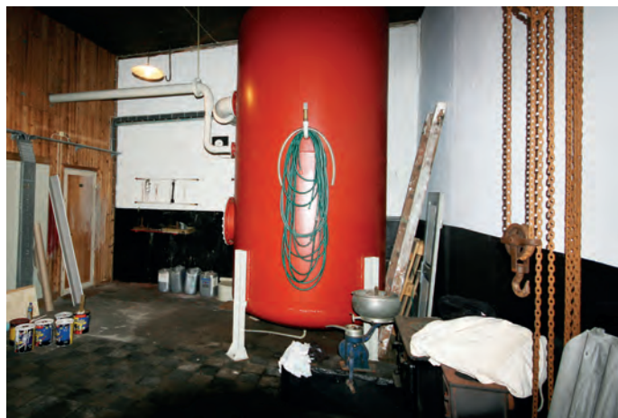
Over: Luftttanker i midtrommet.
