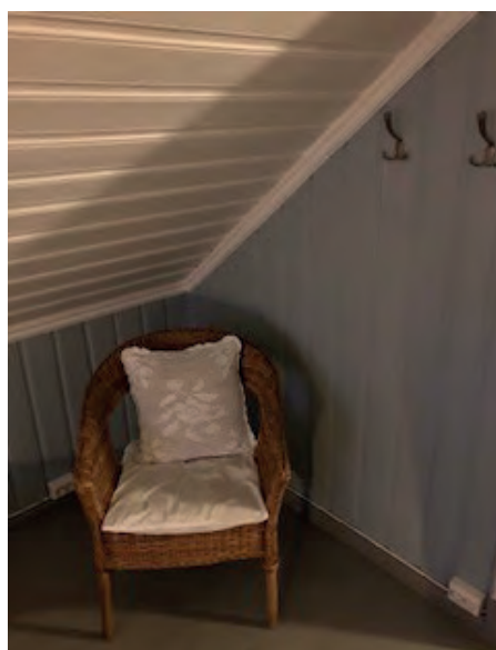
Over: Flere nymalte overflater i 2. etasje.
