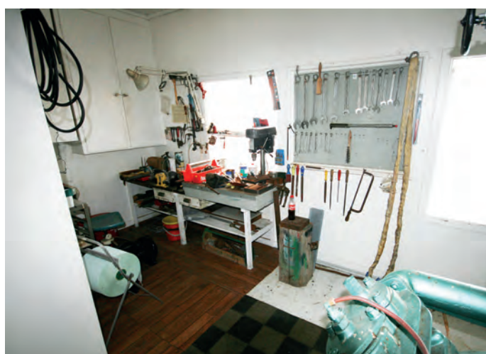
Over: Del av maskinrommet.
