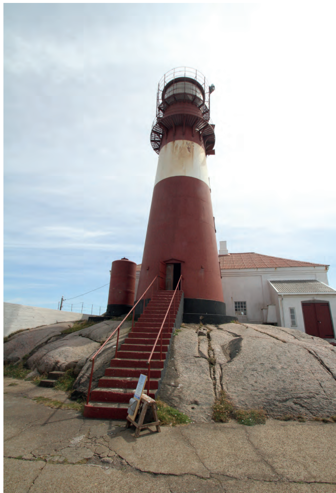
Over: Betongtrapp opp til inngang.
