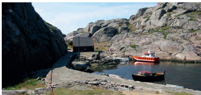
Over: Ved naustet blir veien en støpt betongvei ned til landingen.
