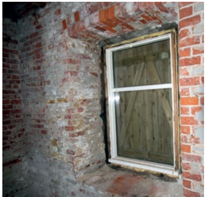
Over, under og til høyre: Kledning på innsiden av ytre murte vegg fjernet i store deler av huset på grunn av store fuktskader.
