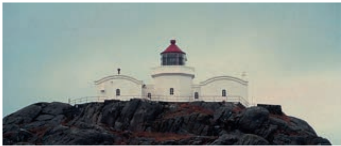
Geitungen fyrstasjon, Rogaland. Foto: Kystverket.
