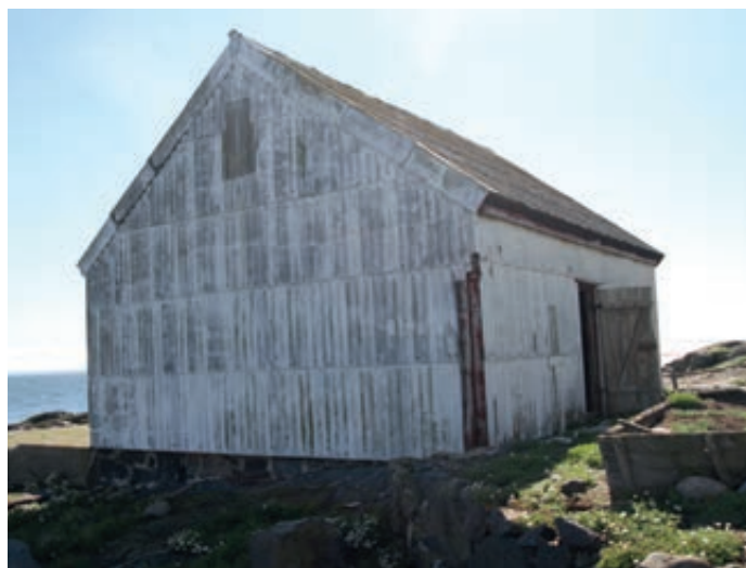
Under: Fasadehjørne mot vest
