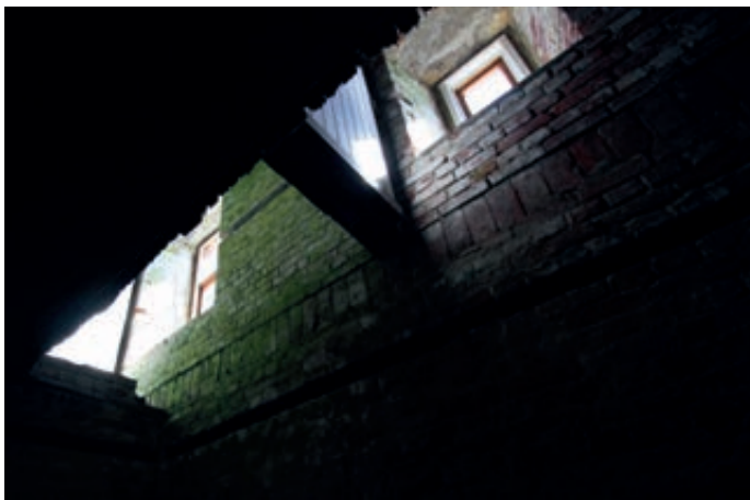
Over, under og til høyre: Kledning på innsiden av ytre murte vegg fjernet i store deler av huset på grunn av store fuktskader.
