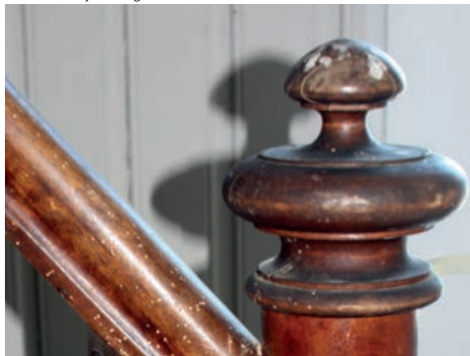
Under: Detalj av megler.
