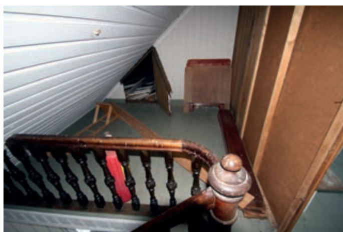
Over: Del av loftsgang 3-201.
