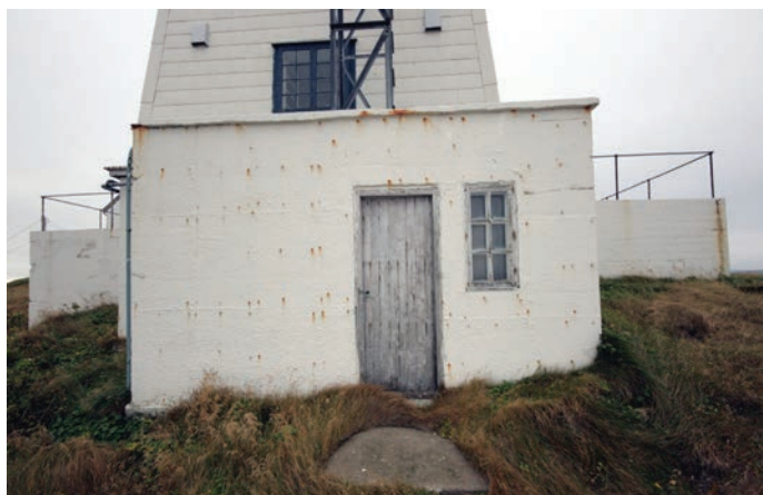
Fyrtårnet med tilhørende tekniske rom, sett fra øst.
