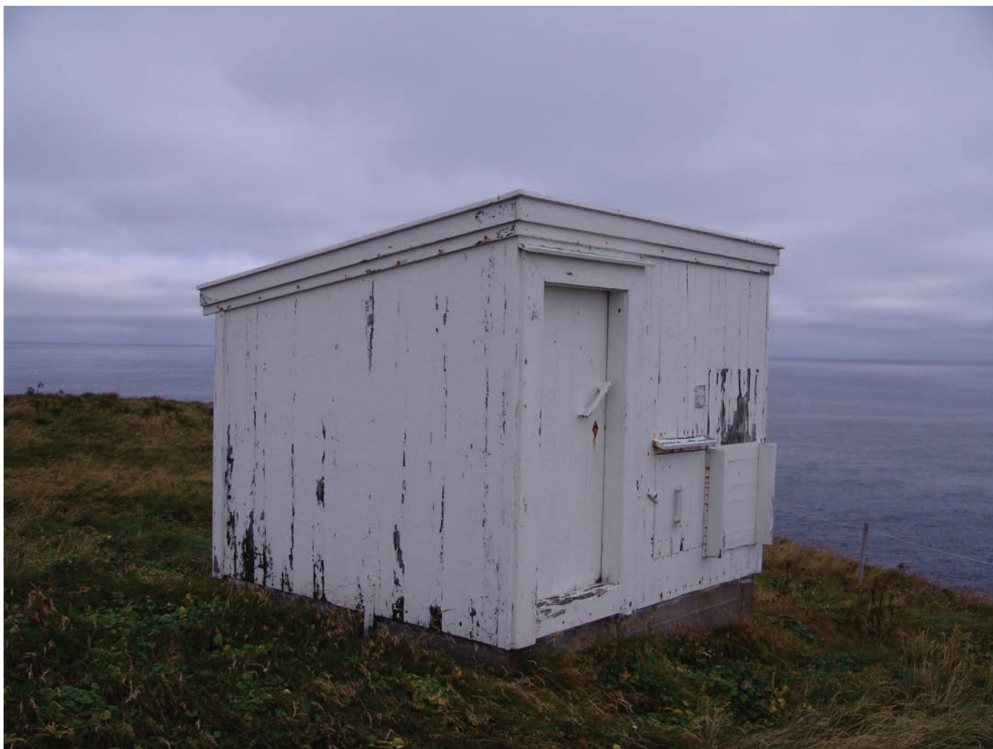
Fasadehjørne mot syd og øst. Foto: Kystverket 15.9.2010.
