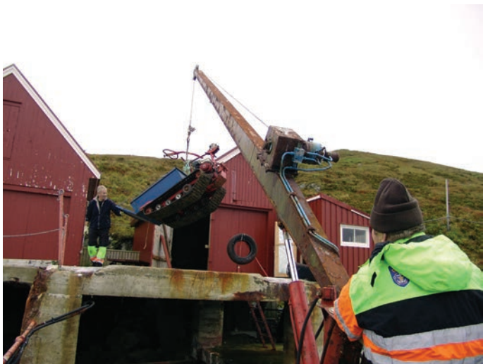
Landing med kran. "Traktoren" løftes ned på brygga.
