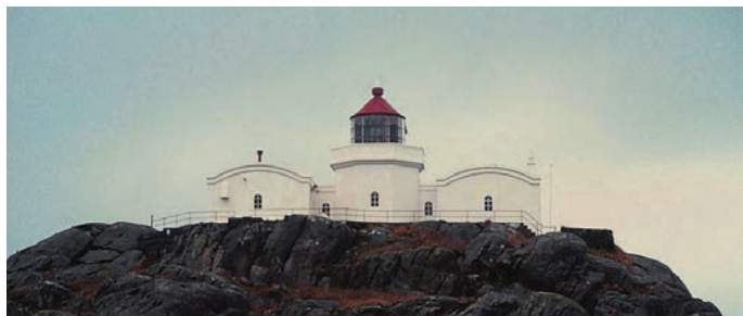
Geitungen fyrstasjon, Rogaland. Foto: Kystverket.
