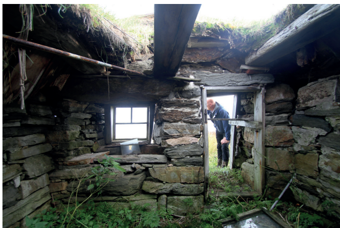
Under: Frontvegg med defekt tak.
