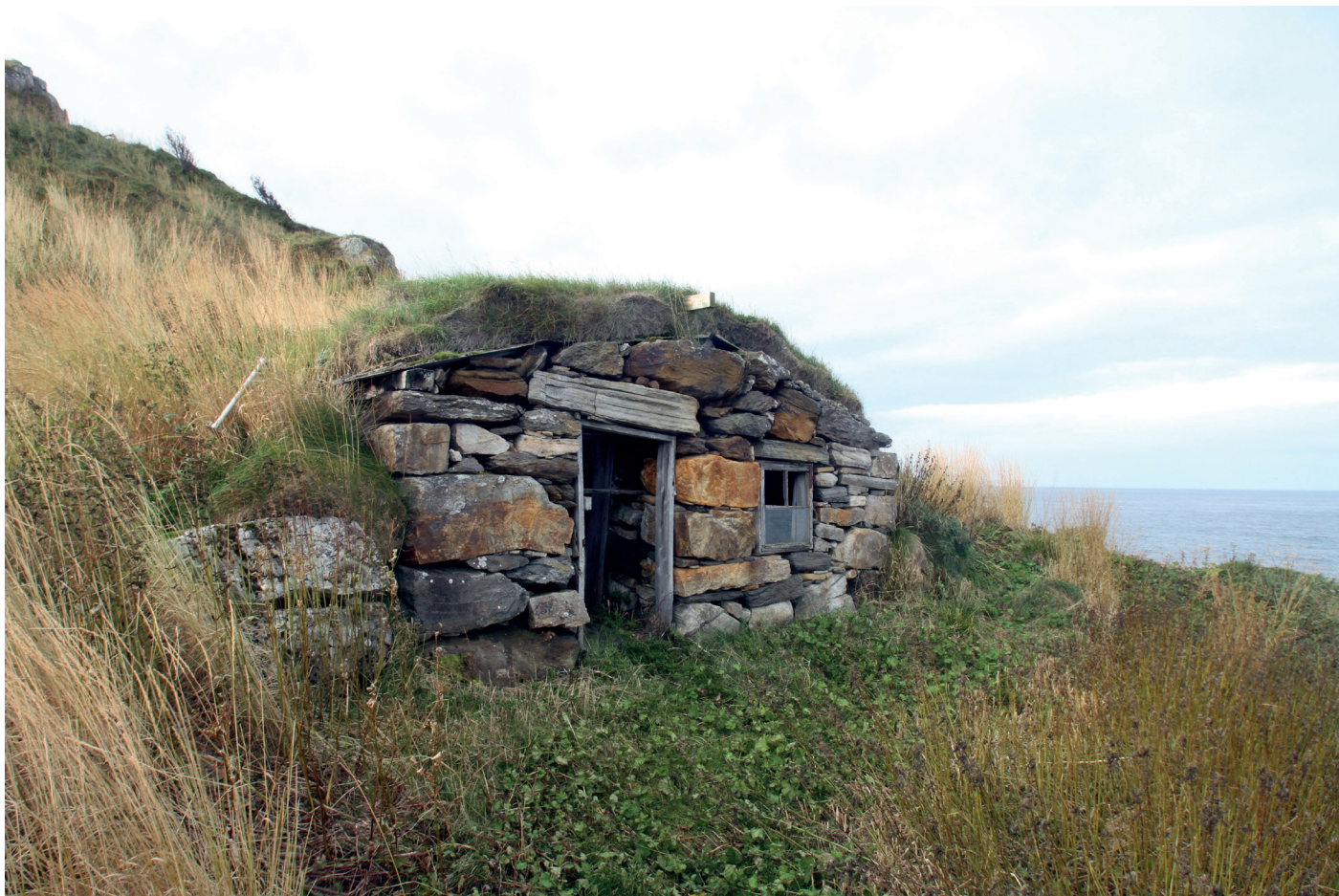
Over: Oljekjelleren, fasade NØ.
