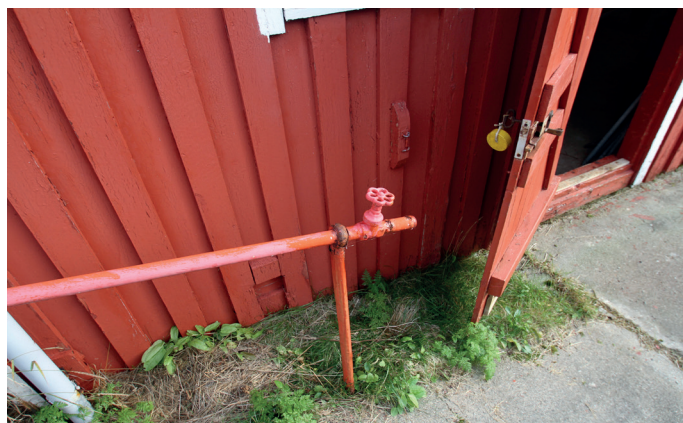
Under: Vegetasjon holder på fuktighet langs ytterveggen.
