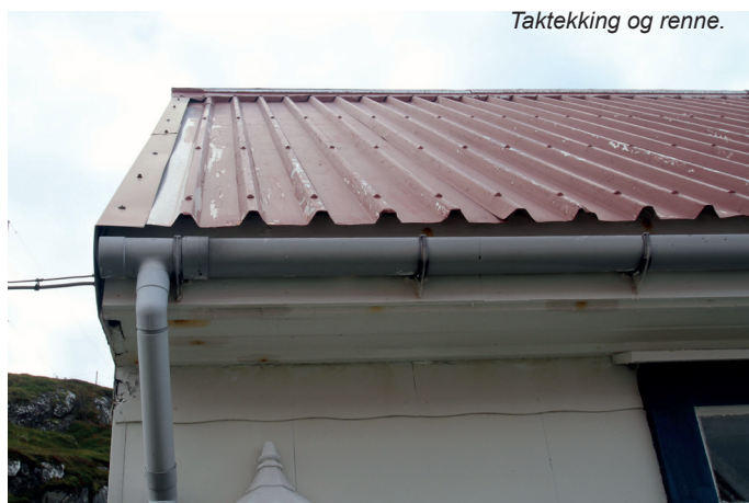
Taktekking og renne.
