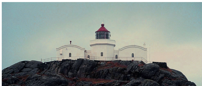
Geitungen fyrstasjon, Rogaland. Foto: Kystverket.
