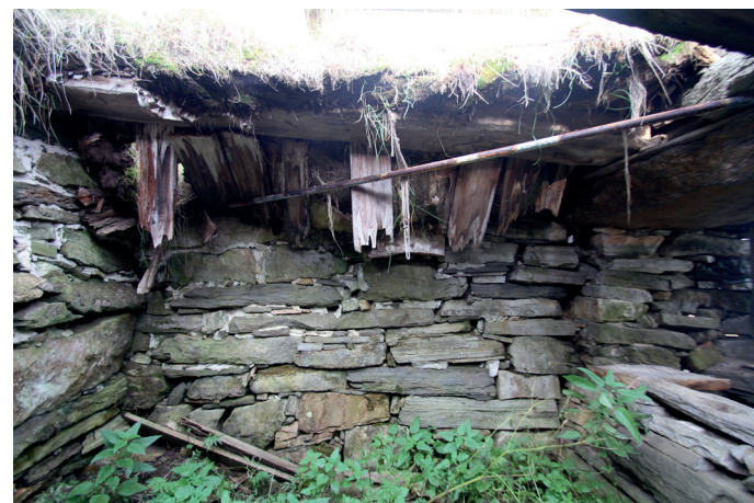
Under: Sidevegg i oljekjelleren, tak defekt.
