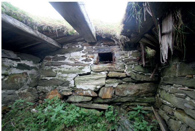
Under: Frontvegg med defekt tak.
