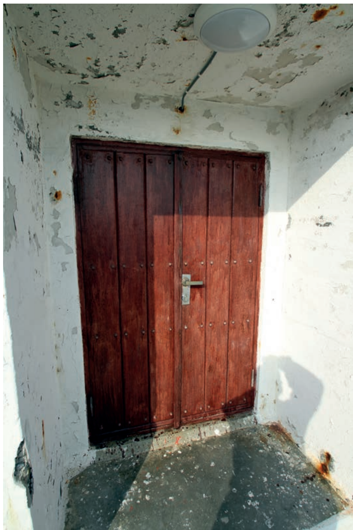
Inngangspartiet og den doble mahognydøren i fyret. Detaljer og hengsler i messing.
