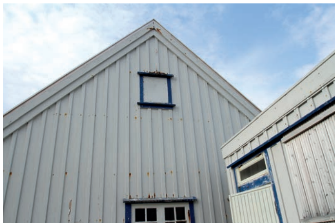
Under og til høyre, 2 vinduer mot nordøst
