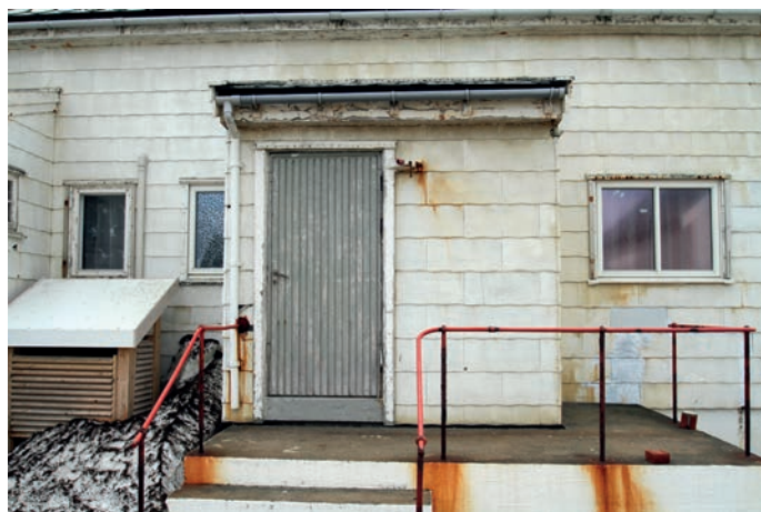
Over: Inngangsparti mot vest, ikke i bruk.
