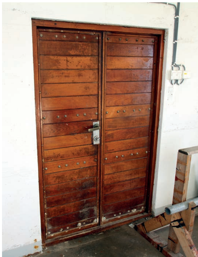
Inngangspartiet og den doble mahognydøren i fyret. Detaljer og hengsler i messing.
