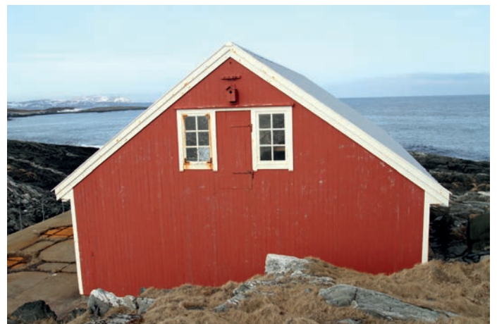
Fasade mot sydøst
