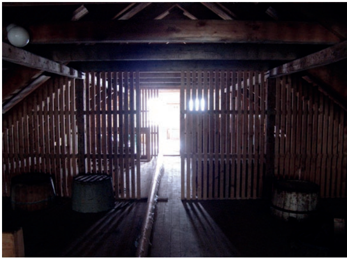
Over: Spilevegger danner avgrensning mellom naustdelene. Under: Naustrom sett mot dobbel skyvedør
