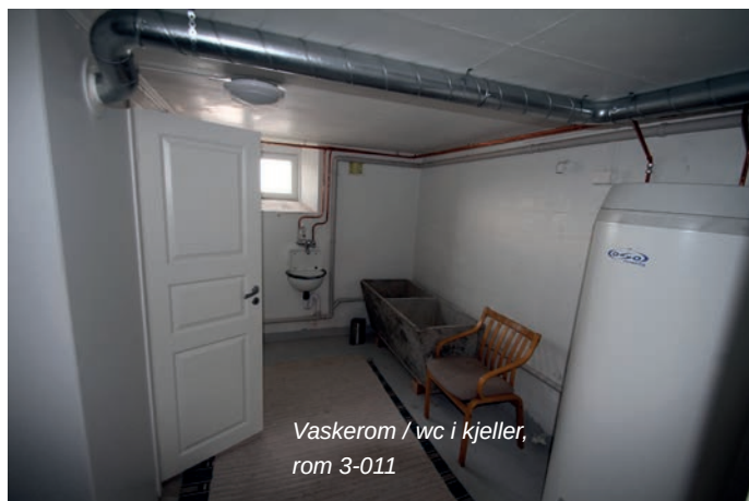
Vaskerom / wc i kjeller, rom 3-011
