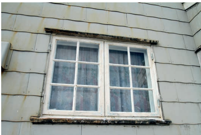
Restaurert vindu - nye detaljer i messing
