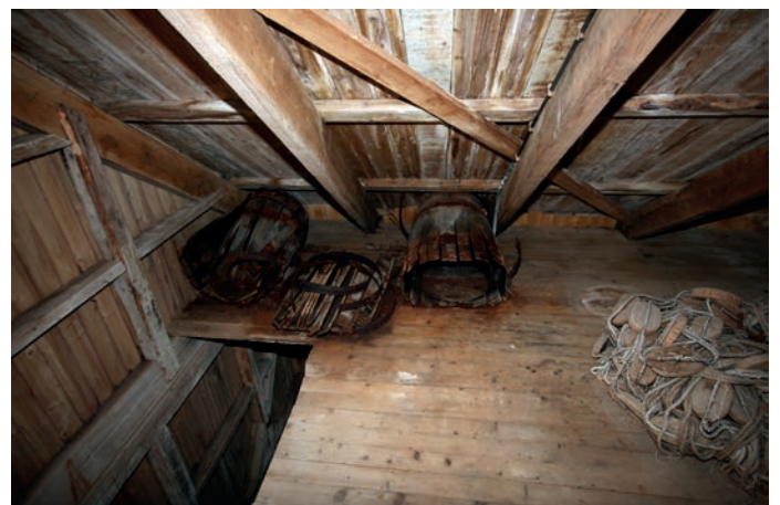
Under: Tak- og veggkonstruksjon
