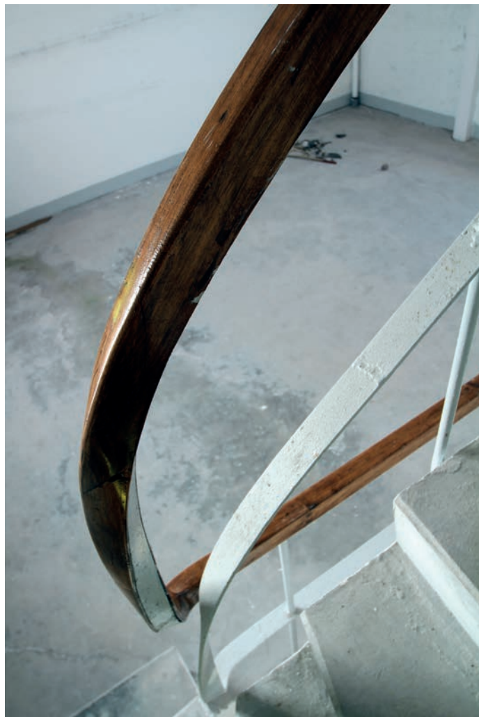
En elegant håndrekke følger rekkverket nedover i etasjene.
