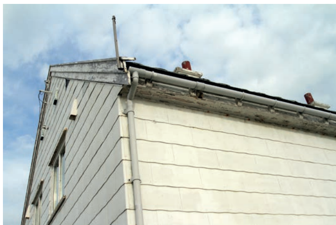
Detalj av takrenne / gesims
