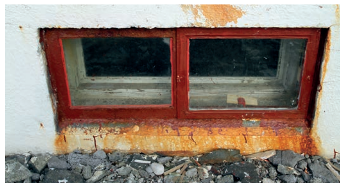
Vinduer. Over: trerammer i 1. etasje. Under: Støpejernsvinfuer i kjeller.
