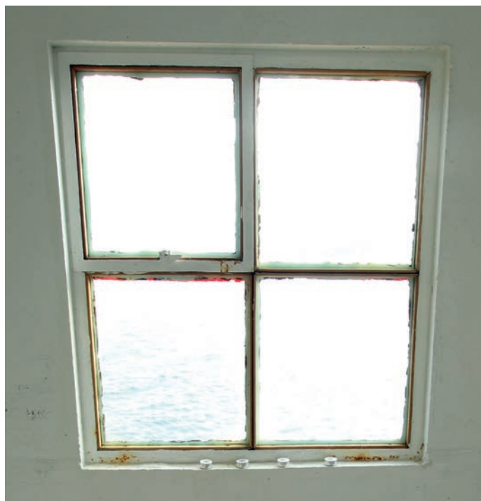
Støpejernsvindu med luftfelt.
