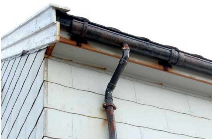
Under: Stadig originale takrenner og nedløp i støpejern.
