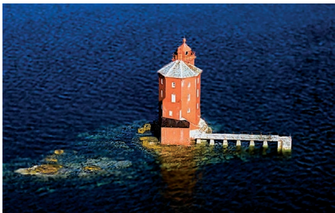
Kjeungskjær fyrstasjon, Sør-Trøndelag. Foto: Kystverket.
