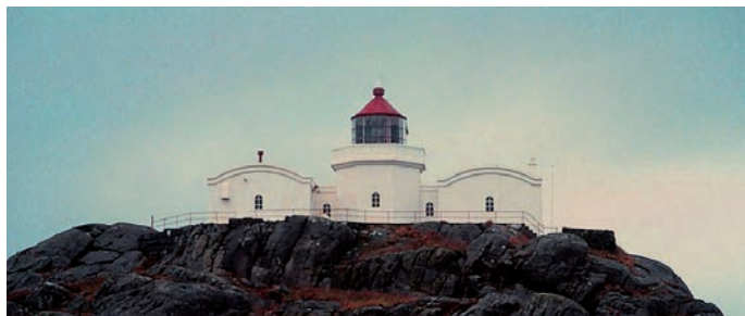
Geitungen fyrstasjon, Rogaland. Foto: Kystverket.
