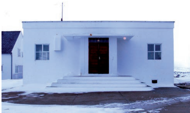
Maskinhusets fasader mot øst -
