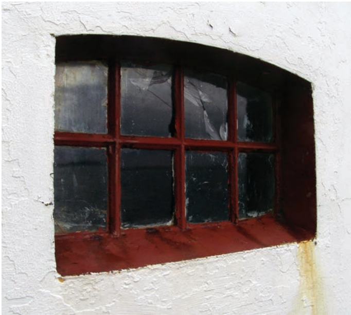
Over: Støpejernsvindu i kjeller.
