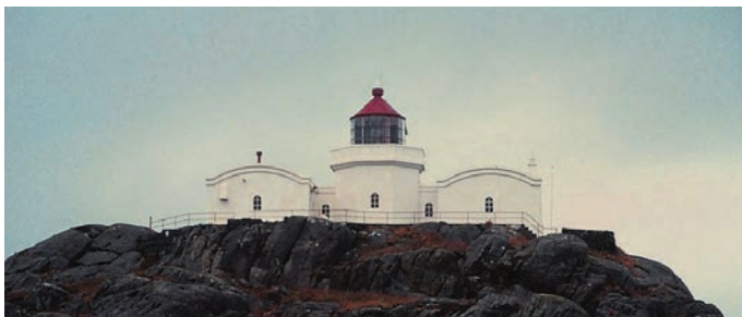
Geitungen fyrstasjon, Rogaland. Foto: Kystverket.
