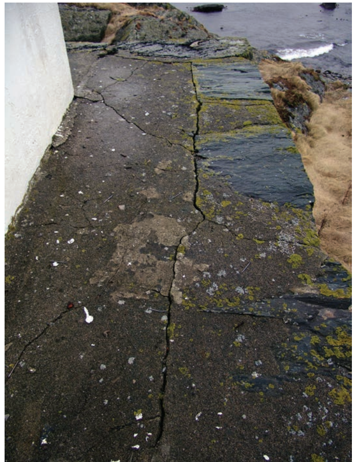
Betongvei / platting langs kjeller-yttervegg rundt boligen.
