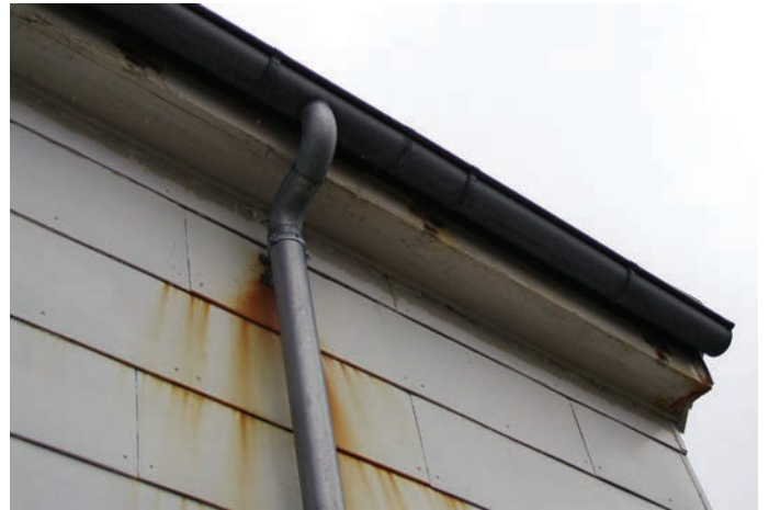
Nye zink.renner og nedløp montert i forbindelse med omlegging av skifertak. Under: Løsning med lysinnslipp via plexiglass over vindfang.
