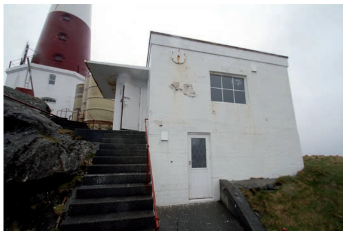
Over: Trapp opp til maskinhuset. Alle foto: Kystverket 6.5.2013
