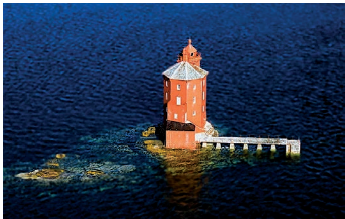
Kjeungskjær fyrstasjon, Sør-Trøndelag. Foto: Kystverket.
