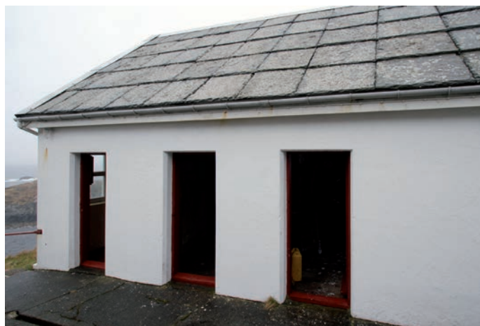
Under: Fasade mot nordøst.
