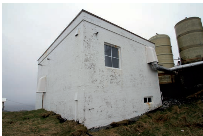
Under: Fasade mot nordvest.
