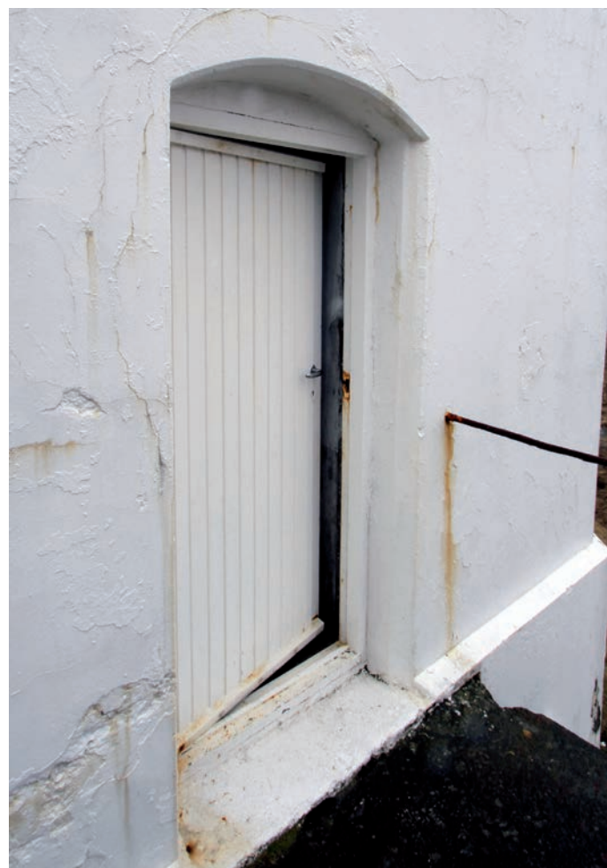
Til høyre: Inngangsdør mot øst.
