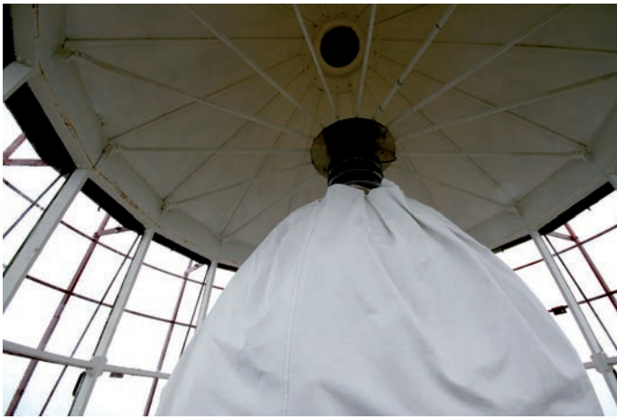
Over: Innepakket og beskyttet linsesystem. Fra fyrlykta. Under: Linsesokkelen og trappa opp.
