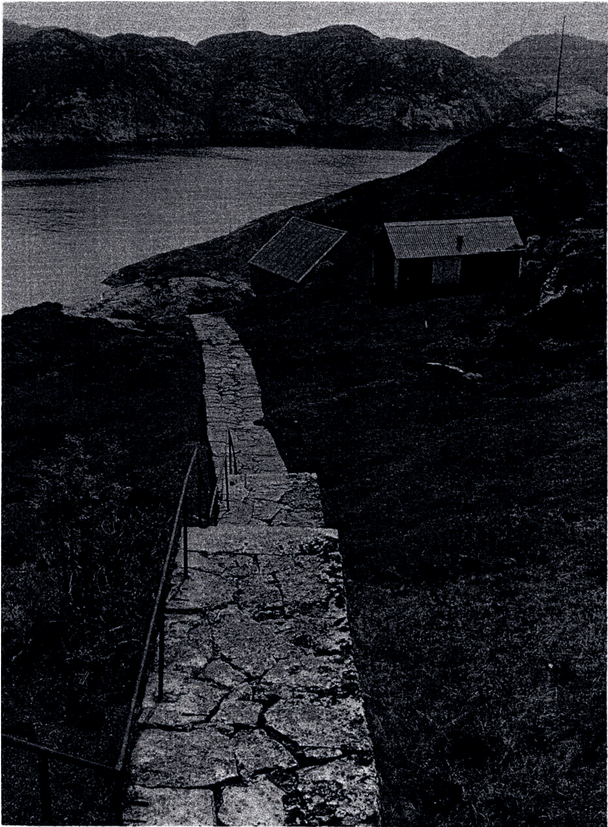
Gråsteinstrapp og vei fra fyr til naust, ca. 400 meter. Nederst mot sjøen ses naustet. Foto 1981.
