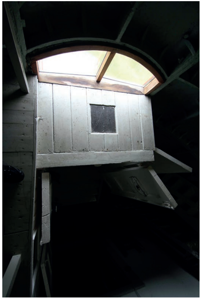
Under: Inngangspartiet med vindfang. Sett ovenfra:
